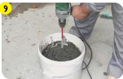
В емкость с 4,5–5 п (для **weber.vetonit 4350**) или 2 л (для **weber.vetonit 6000**) чистой воды засыпать 25 кг сухой смеси. Перемешать дрелью-миксером (400–600 об/мин) до однородной массы (1–2 мин). Смесь добавлять в воду, а не наоборот. Раствор использовать в течение 30 минут (20–30 минут для **weber.vetonit 4350**).
