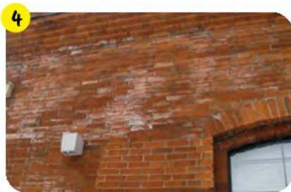
Если в обычный плиточный клей для защиты от замерзания добавить морозостойкие добавки, то по окончании работ на фасаде появятся трудноудаляемые высолы.
