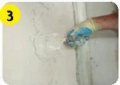
Приготовленный штукатурный раствор в течение 40 мин после затворения набросать на поверхность кельмой слоем 5–50 мм, локально – до 70 мм, после чего разровнять правилом.
