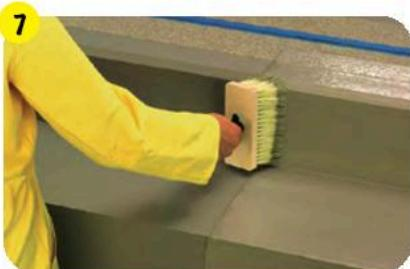
Нанести строительной кистью, шпателем или напылением три последовательных слоя **weber.tec 824**. Между нанесением слоев для высыхания должно пройти минимум 4 часа. Каждый слой наносить перпендикулярно предыдущему.
