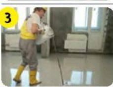
3 Нанести наливной пол **weber.vetonit 4100** вручную или насосом на основание слоем от 2 до 30 мм.
