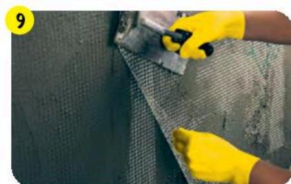
На поверхности смонтированной теплоизоляции создать базовый армированный штукатурный слой при помощи **webertherm S100 winter** и фасадной щелочестойкой сетки (например, **webertherm 2000**).
