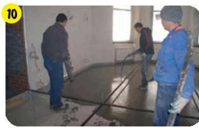
Нанести материал на основание так, чтобы толщина слоя стяжки над трубой теплого пола была в 3 раза больше ее диаметра. Распределить материал стяжки по поверхности шпателем. Наливной пол **weber.vetonit 4350** – самовыравнивающийся, а ровнитель **weber.vetonit 6000** требует ручной укладки и трамбовки.
