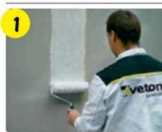
Для повышения прочности сцепления клеевого раствора с основанием перед монтажом теплоизоляции обработать поверхность при помощи грунтовки **vetonit prim multi universal**, разбавленной 1:1 с чистой водой.
