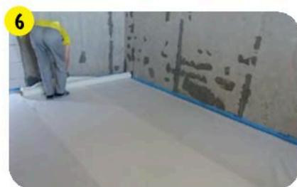
Закрыть плиты утеплителя геотекстилем ( $140 \text{ г}/\text{м}^2$ ) или ПЭ-пленкой.
