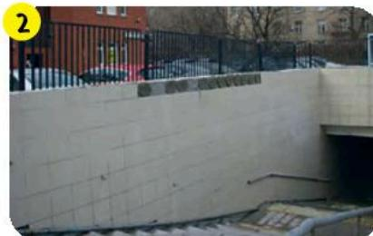
Если основание выравнивали с помощью плиточного клея с высокой усадкой, то могут образоваться трещины на облицовке и со временем облицовка может отслоиться.
