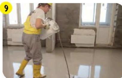
Выпить наливной пол на основание, распределить его по поверхности стальным гладким шпателем или рейкой-правилом. Наливной пол **weber.vetonit 4100** применяется для выравнивания слоем 2–30 мм.
