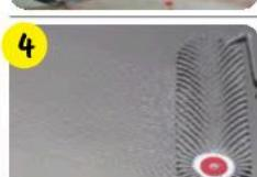
4 Распределить материал по поверхности широким шпателем, гладилкой или трамбовщиком, разровнять и за гладить.
