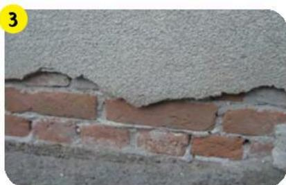
При передозировке противоморозных добавок образовавшиеся соли вызывают ослабление затвердевшего раствора и его разрушение.
