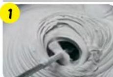
20 кг **weber.tec 930** смешивать с 3,6–4,0 л воды в течение ≈ 4 мин до образования смеси без комков. Через 3–5 мин размешать еще раз. Воду не доливать.
