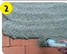
Допускается нанесение штукатурки при помощи сжатого воздуха и краскопульта, размер сопла должен составлять не менее 3 размеров зерна декоративной штукатурки (например, для 1,5 мм «шубы» размер сопла должен составлять не менее 4 мм).
