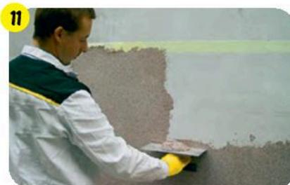
Не ранее чем через 24 часа на засушливую и высушенную поверхность нанести декоративную мозаичную штукатурку **weber.pas marmolit**. После высыхания штукатурки поверхность желательно дополнительно защитить с помощью фасадного гидроизолатора **weber.tec 774**.
