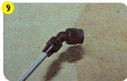
**9** Увлажнить поверхность водой так, чтобы поверхность сохранила абсорбирующую способность.
