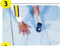
Нанести зубчатым шпателем на поверхность, которая может быть облицована в течение 20 мин.
