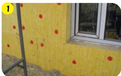
Неправильно установленная теплоизоляция (T-образныестыки) вызывает образование трещин в штукатурном слое.
