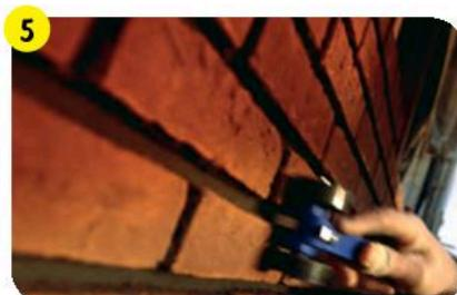
Если нет других указаний, через несколько минут после кладки обработать швы; время задержки зависит от температуры воздуха, раствора и кирпичей, а также от уровня водопоглощения кирпичей. Шов выровнять и загладить при помощи металлической расшивки, а в случае растворов светлых тонов – пластиковой или деревянной расшивкой или специальным инструментом.
