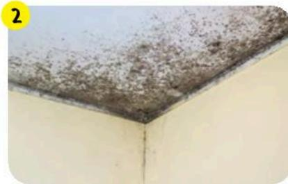
Из-за некачественно выполненных гидроизоляционных работ или их отсутствия во время дождя влага просачивается в помещение под террасой или кровлей и разрушает отделку.
