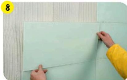
Наклеить плиточную облицовку. Вдавливать ее в клей с усилием. Плиточный клей должен на треть заполнять межплиточный шов. В процессе наклейки следить, чтобы под плиткой не образовывалось воздушных пузырей.
