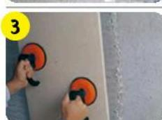
Корректировать положение плит можно в течение 20 мин после укладки. Вдавливать плитку в клей с усилием. Клей не должен заполнять шов более чем наполовину.
