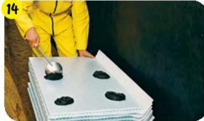
Для защиты изоляции (только после полного ее высыхания) наклеить панели из полистирола при помощи точечного нанесения **weber.tec Superflex 10**.
