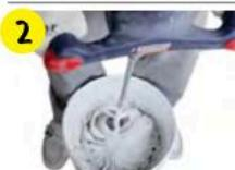
Мешок (30 кг) сухой смеси постепенно высыпать в емкость с 12–15 л чистой воды при перемешивании. Рекомендуемая температура воды +10 °C. Смешивать дрелью с насадкой в течение 1–3 мин до получения однородной консистенции.
