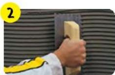
2 Нанести зубчатым шпателем на поверхность, которая может быть облицована в течение 20 мин.
