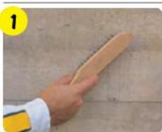
Механически очистить основание от пыли, наледи и веществ, ослабляющих адгезию (для **weber.min winter**). За 12–24 ч до нанесения декоративной штукатурки основание обработать грунтовкой **vetonit prim uni** при помощи кисти или валика.
