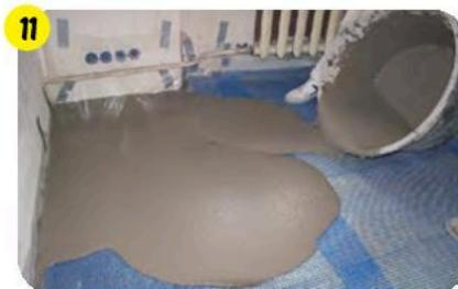
Вылить материал на основание, распределить его по поверхности стальным гладким шпателем или раклей.
