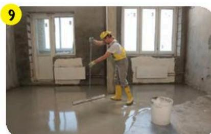
Вылить наливной пол на основание, распределить его по поверхности стальным гладким шпателем. При необходимости прокатать игольчатым валиком.
