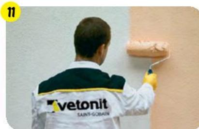
Окраску затвердевшей поверхности **weber.min winter** производить только при условии, что среднесуточная температура за 5-7 суток составляет не ниже +15 °C. Окрасить в два слоя при помощи **weber.ton micro V** или **weber.ton akrylat**.
