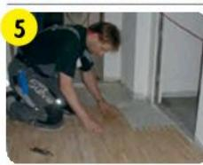
Через 4 ч, когда по полу уже можно ходить, перенести деформационные швы на верхний слой стяжки. Через 1–21 сут уложить напольное покрытие, предварительно заполнив прорезанные швы эластичным материалом для швов.
