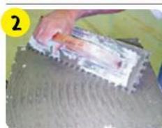
Нанести клей зубчатым шпателем на поверхность, которая может быть облицована в течение 20 мин. При укладке керамогранита на полы или снаружи помещений нанести клей не только на основание, но и на обратную сторону плитки.
