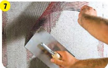
Не ранее чем через 24 часа после приклеивания теплоизоляции создать на ее поверхности армированный слой, уложив панцирную сетку **weber.therm 2600** в нанесенный клеевой раствор **weber.therm S100**.
