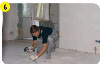
Удалить масло, жир и другие загрязнения механическим способом. Устраниить значительные неровности основания ( $\geq 10$  мм). Закрыть коммуникации в полу изоляционными панелями или быстровердеющим ровнителем **weber.vetonit 5000**.
