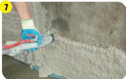
Нанести на поверхность штукатурную смесь **weber.vetonit profi gyps** ручным или механизированным способом. Для выравнивания гладких бетонных оснований поверхность основания предварительно обработать грунтовкой **vetonit prim contact**.
