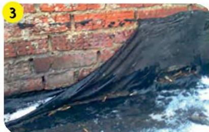
Защита цоколя от влаги с помощью битумной гидроизоляции не позволяет прикрепить на нее плитку.
