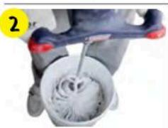
Мешок (30 кг) сухой смеси постепенно высыпать в емкость с 10,5–13,5 л чистой воды при перемешивании. Рекомендуемая температура воды +10 °C. Смешивать дрелью с насадкой в течение 1–3 мин до получения однородной консистенции.
