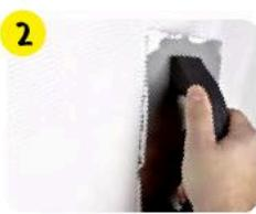
**2** Нанести зубчатым шпателем на поверхность, которая может быть облицована в течение 30 мин. Для укладки мозаики рекомендуется использовать максимально тонкий слой от 1 мм, чтобы швы оставались чистыми, а мозаика легла ровно по основанию. Максимальная толщина слоя 10 мм.
