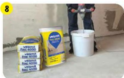
Залить в емкость 5,2–5,4 л чистой воды и смешать с 20 кг **weber.vetonit fast 4000**. Перемешать при помощи дрели-миксера (400–600 об/мин) до однородной массы в течение 1–2 минут. Раствор можно использовать в течение 30 минут.
