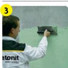
Шпателем (гладилкой) из нержавеющей стали наносить штукатурку на загрунтованную поверхность на толщину, равную размеру зерна при рифленой фактуре («короед») и 1,5-кратному размеру зерна — при зернистой («шуба»). Стыковать участки нанесения штукатурки следует «по-живому», до начала ее высыхания.
