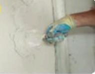
**3** Приготовленный штукатурный раствор в течение 40 мин после затворения набросать на поверхность кельмой слоем 5–50 мм, локально – до 100 мм, после чего разровнять правилом.
