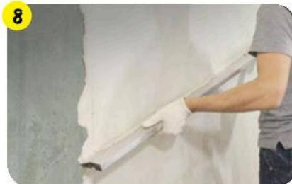
После шлифования и обеспыливания поверхности штукатурки выполнить финишное выравнивание при помощи **weber.vetonit LR+** или **weber.vetonit KR**.
