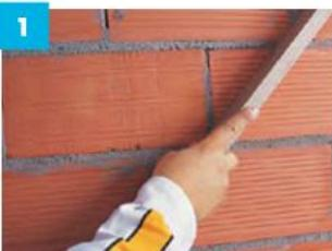
Перед началом работ очистить основание от загрязнений, жира и остатков раствора. Удалить покрытия и штукатурки со слабым или недостаточным сцеплением с основанием. Изоляционный материал можно наклеивать на отремонтированное основание только после высыхания ремонтных материалов (не ранее 48 ч). Максимальное отклонение от плоскости основания не должно быть более 10 мм на 2 м.
