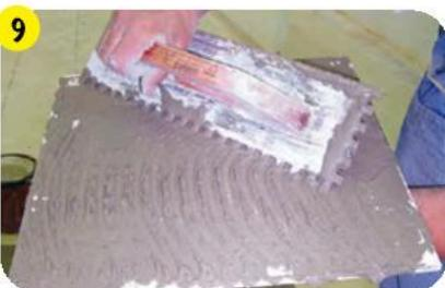
Нанести клей на основание ровным краем шпателя, а затем разровнять зубчатым шпателем, размер зубцов которого тем больше, чем больше плитка. При работе на фасаде рекомендуется применять двойную обмазку: клей наносить как на основание, так и на всю поверхность тыльной стороны плитки.
