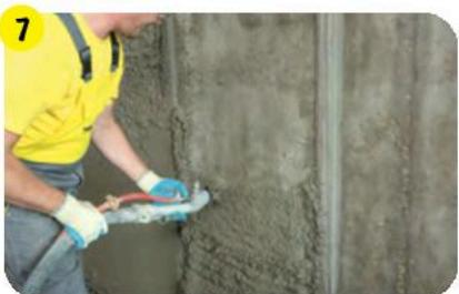
Нанести на поверхность штукатурную смесь **vetonit TT30 light** или **weber.vetonit TT40** ручным или механизированным способом. **Vetonit TT30 light** применять при толщине одного слоя 2–30 мм (локально до 50 мм), **weber.vetonit TT40** – до 40 мм.
