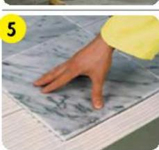
5 Через 3–4 ч, когда по полу уже можно ходить, перенести деформационные швы на верхний слой стяжки. Через 3–21 сут уложить напольное покрытие, предварительно заполнив прорезанные швы эластичным материалом для швов.
