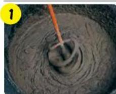
Залить в емкость 4,50–5,25 л чистой воды и смешать с 25 кг weber.vetonit block при помощи дрели-миксера (400–600 об/мин) до однородной массы. Дать отстояться 5 мин, еще раз перемешать. Смесь добавлять в воду, а не наоборот.
