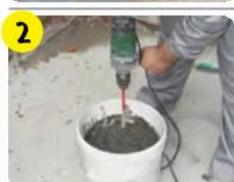
2 В емкость с 3,2–3,6 л чистой воды засыпать 20 кг (мешок) **weber.vetonit 4615**. Перемешать дрелью-миксером (400–600 об/мин) до однородной массы (1–2 мин). Смесь добавлять в воду, а не наоборот. Использовать в течение 20 мин.
