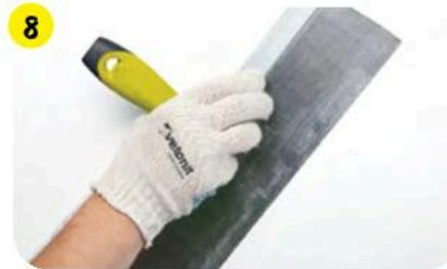
Широким жестким шпателем полностью выровнять швы, чтобы получилась ровная и гладкая поверхность. После высыхания смеси швы обработать мелкой шлифовальной бумагой.
