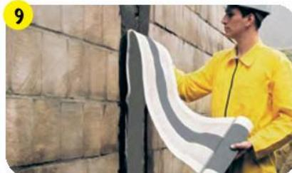
Деформационные швы зданий заизолировать с помощью изоляционной ленты **weber.tec Superflex B240/B400** с флисовым покрытием. Края ленты наклеить на стену, используя **weber.tec Superflex 10**.
