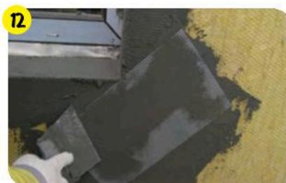
Углы оконного проема перед созданием базового штукатурного слоя усилить полосками из сетки (размером не менее 200 × 300 мм).
