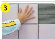
3 Корректировать положение плитки можно в течение 15 мин после укладки.
