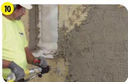
**10** Нанести базовый слой штукатурки, полностью закрыв сетку раствором **weber.vetonit 414**.
