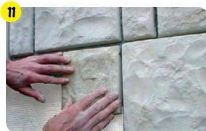
Укладывать плитку с зазором не менее 4–6 мм.
