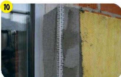
Углы усилить специальным уголком с сеткой, утопив его в тонкий слой клеевого раствора.
