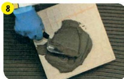
Нанести клей на обратную часть плитки для обеспечения 100%-ного контакта и заполнения kleевым слоем.
