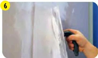
На подготовленное основание широким шпателем нанести **weber.vetonit JS** так, чтобы смесь полностью заполнила углубление шва и края соседних плит.
