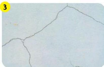
Трещины на фасаде могут быть вызваны неправильной сушкой штукатурного покрытия (под прямыми солнечными лучами или на сильном ветре).
