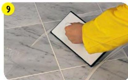
Для затирки межплиточных швов 2–8 мм следует использовать белый клей-гель **vetonit comfort extreme fix**. Для затирки швов 1–6 мм использовать цветную цементную затирку **weber.vetonit decor**.
