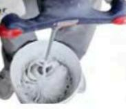
Мешок (20 кг) сухой смеси постепенно высypать в емкость с 8–10 л чистой воды, одновременно перемешивая. Рекомендуемая температура воды +20 °C. Смешивание производить при помощи дрели с насадкой 1–3 мин до получения однородной консистенции. Приготовленная порция раствора должна быть израсходована не позднее 40 мин после затворения.
