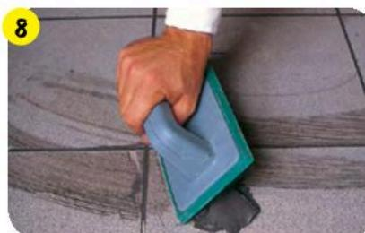
Не ранее чем через 24 часа заполнить швы затиркой **weber.vetonit decor** (швы 1–6 мм) или **vetonit rapid** (швы 2–30 мм). Включать обогрев пола не раньше чем через 7 суток.
