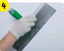
При финишном выравнивании проверить сцепление старой краски с основой, зашпаклевать поверхность. Каждый последующий слой наносить на полностью высохший предыдущий. Высохшую поверхность обработать шлифовальной бумагой и обеспылить.
