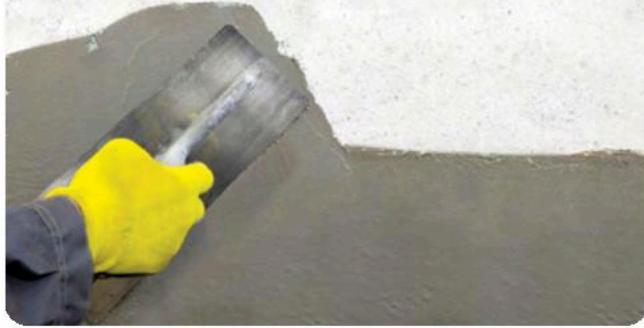
**weber.tec 930** может наноситься на любые минеральные основания — бетон, кирпич, штукатурку. Используется для конструкций, не подверженных трещинообразованию. В противном случае необходимо использовать **weber.tec 824**.
