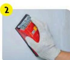
После высыхания поверхность обрабатывать при помощи шлифовальной бумаги (рекомендуется зернистость P400 и выше). Для более легкой обработки поверхности рекомендуется шлифовать ее сразу после высыхания материала. Обеспылить поверхность перед нанесением следующего слоя. При многослойном выравнивании каждый последующий слой наносить на полностью высохший предыдущий.
