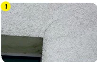
Неправильно установленные угловые косынки могут вызывать трещины на фасаде.
