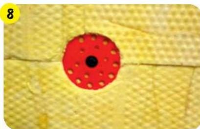
Через 24-72 часа после монтажа теплоизоляции зафиксировать ее с помощью фасадных дюбелей (согласно схеме дюбелирования).
