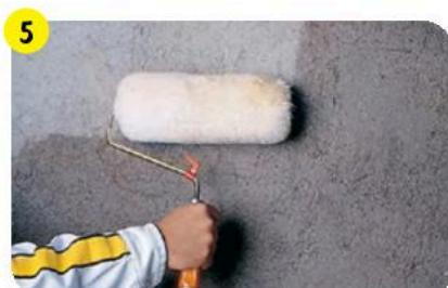
При температуре выше +5 °C обработать поверхность грунтовкой **vetonit prim multi universal**.
