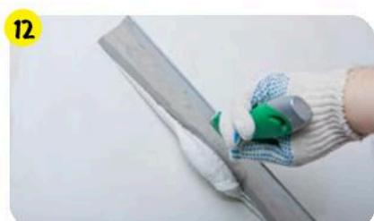
Суперфинишное выравнивание под покраску выполнить при помощи **vetonit LR pasta brilliant**. Перед покраской рекомендуется обработать поверхность при помощи грунтовки **vetonit prim multi universal**, разведенной водой 1:1.
