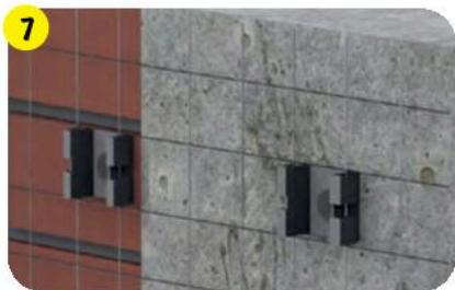
**7** Закрепить сетку на поверхности стены при помощи крепежа.
