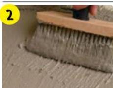
Материал наносить обильно, интенсивно и равномерно по всей поверхности щеткой, кистью или кельмой за 2–3 раза. Общая толщина сухого слоя должна быть не менее 2 мм в любом месте гидроизоляции.
