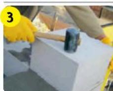
Уложить блоки, слегка вдавливая в слой нанесенного клея. Выравнивать уровень блоков с помощью резинового молотка.
