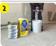
2 В емкость с 4,4–4,8 л чистой воды засыпать 20 кг (мешок) **weber.vetonit 4100**. Перемешать дрелью-миксером (400–600 об/мин) до однородной массы (1–2 мин). Смесь добавлять в воду, а не наоборот. Использовать в течение 20–30 мин.
