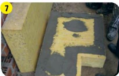
Клеевой раствор наносить таким образом, чтобы при монтаже теплоизоляции на стену он не попадал на раму окна, то есть не создавался мостик холода.
