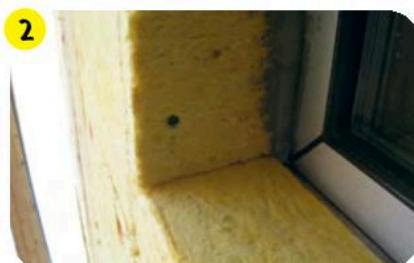
Швы, замазанные kleевым раствором, снижают теплозащитные свойства системы
