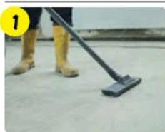
Очистить, обеспылить основание и за 4 ч перед нанесением наливного пола обработать грунтовкой **vetonit MD 16 superconcentrate** или **vetonit prim multi universal**, используя щетку. Определить перепады высот.
