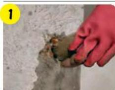
Для остановки течи материалом **weber.tec 935** максимально густой консистенции заполнить трещины и швы с протекающей водой.
