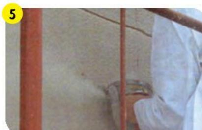
С помощью фрезы по камню нанести на поверхность фасада горизонтальные и вертикальные разрезы шириной около 8 мм с шагом от 15 × 15 см до 30 × 30 см (в зависимости от состояния фасада), углубив их в теплоизоляционный материал на 3 мм. Все непрочные элементы удалить.
