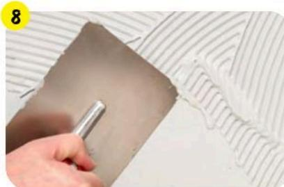
На высохшую гидроизоляцию нанести белый клей-гель **vetonit comfort extreme fix**. Уложить плитку, используя двойную обмазку. Минимальная ширина шва между плитками в бассейне 3 мм. Более узкий шов не способен компенсировать деформации в основании, и покрытие быстро разрушается.
