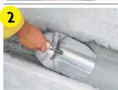
Закругления выполнить из пластичной массы **weber.tec 933** на увлажненной поверхности с использованием соответствующего инструмента, например разглаживающей закругленной кельмы.
