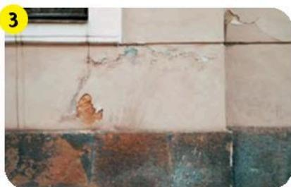
Если паропроницаемость штукатурного слоя меньше паропроницаемости основания, то водяные пары, выходящие из основания, будут скапливаться на границе «основание – штукатурка», приводя к ослаблению прочности сцепления между ними и образованию трещин на поверхности штукатурного слоя.
