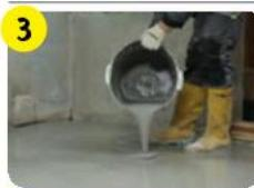
Нанести наливной пол **weber.vetonit fast 4000** вручную или насосом на основание слоем от 3 до 80 мм.
