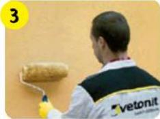
Неокрашиваемые поверхности, например стекло, деревянные и пластиковые рамы, металлические конструкции, необходимо защитить от попадания краски, тщательно укрыть до начала работ. Сильно впитывающие и мелящие основания при необходимости предварительно обработать грунтовкой **vetonit prim facade** без разбавления или **vetonit prim multi universal**, разведенной с водой 1:1.
