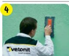
Сразу после нанесения, не допуская обветривания поверхности, создать фактуру, затирая пластиковой гладилкой. Излишки связующего, образующиеся на рабочей поверхности терки, периодически удалять, но не возвращать обратно в ведро с материалом.
