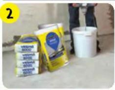
В емкость с 2,0 л чистой воды засыпать 25 кг (мешок) **weber.vetonit 6000**. Перемешать дрелью-миксером (400–600 об/мин) до однородной массы (3–5 мин). Смесь добавлять в воду, а не наоборот. Использовать в течение 30 мин.
