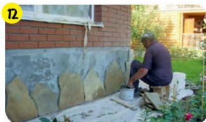
Зазор между плитами для компенсации линейных деформаций должен составлять не менее 4 мм. Заполнить швы цветной цементной затиркой **vetonit rapid** (для швов 2–30 мм) с использованием специального шприца-пистолета. Для сохранения внешнего вида натурального камня и придания ему водоотталкивающих свойств обработать гидрофобизирующим составом **weber.tec 774**.
