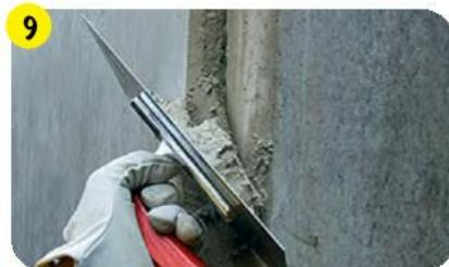
Сильно поврежденные участки следует отремонтировать быстро схватывающимся составом **weber.tec 933**.
