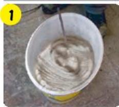
**1** Необходимо провести подготовку поверхности (выравнивание, очистку, обеспыливание). В емкость с 7,6-8,4 л чистой воды засыпать 20 кг **vetonit comfort super fix**. Смешать деревьо-миксером до однородной массы. Дать отстояться 5 мин и еще раз перемешать.
