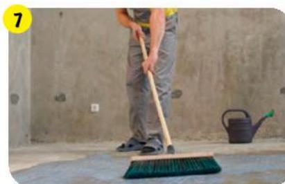
Удалить масло, жир и другие загрязнения механическим способом. Обеспылить основание. Обработать основание грунтовкой-концентратом **vetonit MD 16 superconcentrate**, разведенной в соответствии с инструкцией на упаковке, либо универсальной грунтовкой **vetonit prim multi universal** без разбавления, используя щетку.
