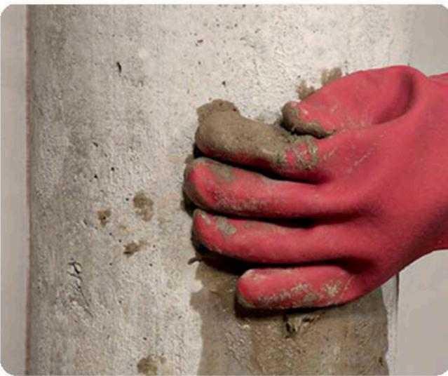
**weber.tec 935** используется внутри и снаружи помещений при изоляции подвалов, фундаментов, резервуаров, бассейнов. После отверждения на него можно наносить гидроизоляционные материалы, например битумные или цементные гидроизоляционные покрытия.
