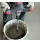
Смешивать при помощи дрели с насадкой в течение 3–5 мин до однородной массы. Дать отстояться раствору в течение 10 мин и еще раз перемешать. Время использования готовой смеси 2 ч с момента затворения водой. Температура использования смеси должна быть в пределах от +5 до +30 °C.
