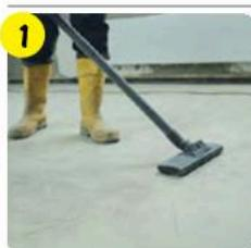
Очистить, обеспылить основание и за 4 ч перед нанесением наливного пола обработать грунтовкой **vetonit MD 16 superconcentrate** или **vetonit prim multi universal**, используя щетку. Определить перепады высот. Выставить точечные реперные маячки **weber.floor level marker**.
