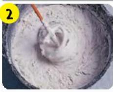
Приготовить раствор согласно инструкции на обратной стороне мешка. Смесь добавить в строго отмеренное количество воды, перемешать до однородной массы без комков, оставить на 5–10 мин и повторно перемешать 1–2 мин.
