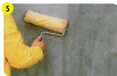
При необходимости выровнять поверхность чаши бассейна с помощью **vetonit REP 45** или **REP 25+**, в зависимости от прочности основания, предварительно увлажнив бетонное основание.
