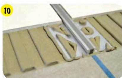
При больших площадях облицовываемых поверхностей их следует разделить деформационными швами на сегменты площадью 25–45 м<sup>2</sup>, при этом соотношение сторон должно быть не более 1:2.
