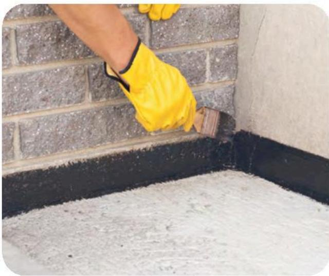
**Vetonit PUR details** – жидкая тиксотропная однокомпонентная полиуретановая мастика, армированная волокном, образующая после застывания бесшовную гидроизоляционную высокогерметичную мембрану, рассчитанную на весь срок службы здания. Содержит растворитель. Отверждается при взаимодействии с влагой, содержащейся в основании и воздухе.
