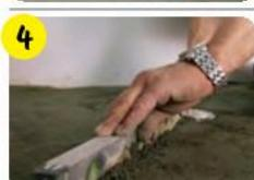
Распределить материал по поверхности, заполняя пространство между маячными рейками. Разровнять и подрезать правилом, при необходимости загладить теркой.
