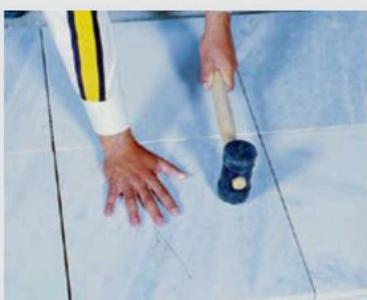
За один проход наносят такое количество клея, чтобы успеть аккуратно уложить плитку до его заветривания. Плитку постепенно выкладывают на нанесенный слой клея, выравнивают, вдавливают и слегка простукивают специальным резиновым молотком. При этом рифы плиточного клея ровномерно распространяются под плиткой, образуя максимальное пятно контакта.
