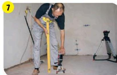
Оценить ровность и горизонтальность пола, используя уровень или нивелир. Разметить высоты основания. Выставить точечные маяки **weber.floor level marker** для контроля толщины стяжки (при слое от 10 мм).
