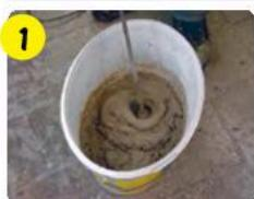
Необходимо провести подготовку поверхности (выравнивание, очистку, обеспыливание). В емкость с 5,5–6,25 л чистой воды засыпать 25 кг клея **weber.vetonit ultra fix winter**. Перемешать дрелью-миксером до однородной массы, выдержать 5 мин и повторно перемешать.
