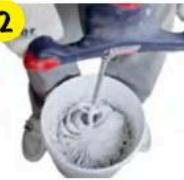
Дать раствору отстояться 10 мин и еще раз перемешать. Смесь пригодна для использования до 24 ч с момента затворения водой (до 3 сут в закрытой таре).
