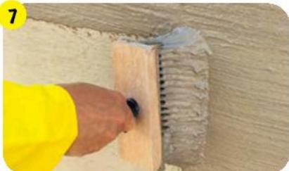
Цоколь, находящийся под воздействием брызг и снега, покрыть цементным гидроизоляционным раствором **weber.tec 824** на 15 см ниже уровня грунта.
