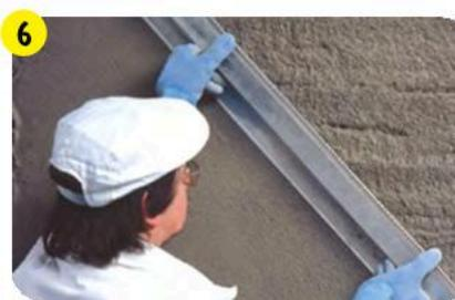
Нанести раствор **weber.vetonit 414** толщиной 5–30 мм (10–12 мм за один слой) и разровнять с помощью правила. Большую толщину можно получить повторным нанесением с промежуточной сушкой первого слоя не менее 24 часов.
