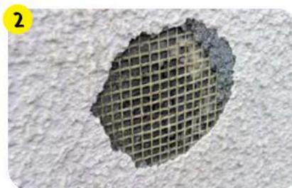
Разрушения фасадного покрытия могут быть вызваны механическими повреждениями.
