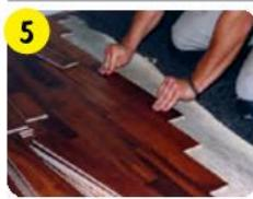
Через 3–4 ч, когда по полу уже можно ходить, перенести деформационные швы на верхний слой стяжки. Через 5–21 сут уложить напольное покрытие, предварительно заполнив прорезанные швы эластичным материалом для швов.
