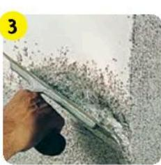
На загруженную поверхность шпателем (гладилкой) из нержавеющей стали нанести слой штукатурки толщиной, равной размеру зерна (при рифленой фактуре – «короед») или 1,5-кратному размеру зерна (при зернистой фактуре – «шуба»). Стыковать участки нанесения штукатурки «по-живому», т. е. до того, как она начнет высыхать.
