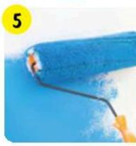
Последующие операции производить после полного высыхания (через 3–4 сут). Выровненную и затвердевшую поверхность окрасить щелочестойкой краской или облицевать плиткой, предварительно удалив с поверхности после зашкуривания. Перед оклейкой обоями или покраской в сухих помещениях обработать поверхность шпаклевками KR или LR+, во влажных помещениях – VH Grey или VH.
