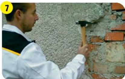
Проверить прочность старого штукатурного покрытия. Удалить непрочно держащуюся штукатурку. Обработать основание с помощью грунтовки **vetonit prim multi universal**, разведенной 1:1.
