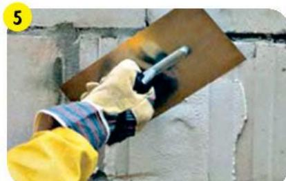
Углубления и швы на поверхности > 5 мм, а также сопряжение фундаментной плиты и стены увлажнить и обработать безусадочным водоизоляционным быстротвердеющим армированным раствором **weber.tec 933**.
