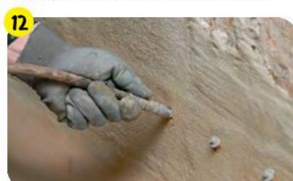
Отверстия очистить от пыли сжатым воздухом, после чего для горизонтальной капиллярной отсечки произвести инъекцию **weber.tec 940E** до заполнения отверстий.
