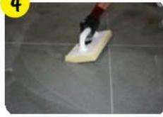
При укладке крупного формата керамогранита и плит необходимо нанести клей не только на основание, но и на обратную сторону отделочного материала.
