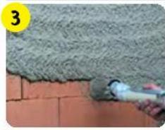
Раствор наносить стальным шпателем, или набрасывая кельмой до нужной толщины слоя (1–4 мм), или механизированным нанесением.
