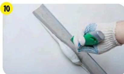
Финишное выравнивание поверхности гипсостроительной плиты выполнить при помощи **weber.vetonit JS**. Смесь наносить механизированным способом напыления или вручную.
