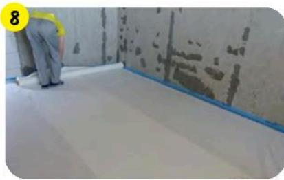
Закрыть минераловатные плиты утеплителя геотекстилем ( $140 \text{ г}/\text{м}^2$ ) или ПЭ-пленкой. Плиты ППС укрывать ничем не нужно.
