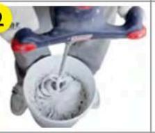
Дать раствору настояться в течение 10 мин и еще раз перемешать. Смесь пригодна для использования до 24 ч с момента затворения водой, до 2 сут при хранении в закрытой таре.
