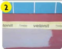
Затем по краям ленты наносится второй слой гидроизоляционного материала. Необходимо следить, чтобы зона растяжения ленты не была покрыта гидроизоляционным материалом.
