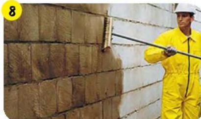
Основание загрунтовать битумной эмульсией **weber.tec 901**, разбавленной водой в соотношении 1:10. Наносить кистью, щеткой или распылением.
