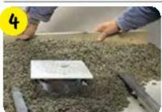
Распределить материал по поверхности, заполняя пространство между маячными рейками. Утрамбовать и уплотнить смесь. Разровнять и подрезать правилом, при необходимости загладить теркой.
