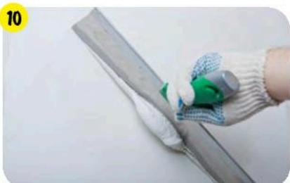
Суперфинишное выравнивание под покраску выполнить при помощи **vetonit LR pasta brilliant**. Перед покраской рекомендуется обработать поверхность при помощи грунтовки **vetonit prim multi universal**, разведенной водой 1:1.
