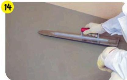
Вылить наливной пол **weber.vetonit 3000** на основание, распределить и разровнять его по поверхности стальным гладким шпателем или кельмой-мечом. Толщина слоя 1–5 мм.
