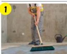
1 Очистить, обеспылить основание и за 4 ч перед нанесением ровнителя обработать грунтовкой **vetonit MD 16 superconcentrate** или **vetonit prim multi universal**, используя щетку. Определить перепады высот. Выставить сплошные маяки.
