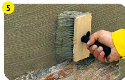
Предварительно слегка увлажнить основание водой, обработать его двумя слоями обмазочной бесшовной эластичной гидроизоляции **weber.tec 824** или жесткой **weber.tec 930** (для недеформирующихся оснований).
