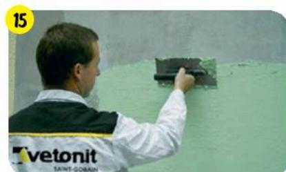
На загрунтованную с помощью **vetonit prim uni** поверхность нанести декоративно-защитную штукатурку.
