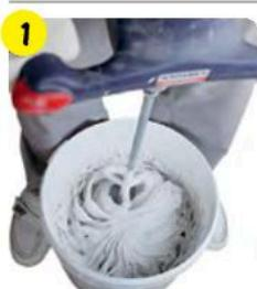
Основание должно быть чистым и твердым. Температура основания и затворенной смеси должна быть не менее +10 °C.
