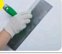
Смесь наносить механизированным напылением или стальным шпателем. Для частичного выравнивания использовать маленький стальной шпатель шириной 30 см.
