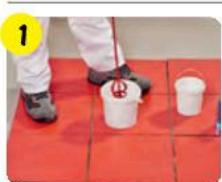
Приступать к заполнению швов необходимо после высыхания клея. Шов должен быть очищен от остатков плиточного клея, пыли, жиров и других загрязнений, препятствующих адгезии. В чистую воду засыпать сухую смесь, перемешать дрелью-миксером до однородной массы. Дать отстояться 5 мин и еще раз перемешать 2–3 мин. Для затирок темных цветов использовать меньше воды и перемешивать 5–7 мин.
