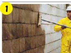
Перед нанесением изоляции поверхности загрунтовать битумной эмульсией **weber.tec 901**, разбавленной водой в соотношении 1:10.
