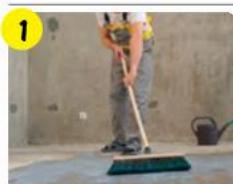
Очистить, обеспылить основание и за 4 ч перед нанесением ровнителя обработать грунтовкой **vetonit MD 16 superconcentrate** или **vetonit prim multi universal**, используя щетку. Определить перепады высот. Выставить сплошные маяки.
