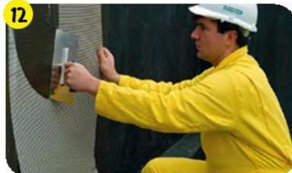
После того как нанесенный слой сменит цвет с коричневого на черный, нанести основной изоляционный слой **weber.tec Superflex 10**. Его толщина зависит от водной нагрузки. При необходимости поверхность армировать стеклосеткой.
