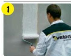
Для обеспыливания и укрепления поверхности рекомендуется обработать основание при помощи грунтовки *vetonit prim facade* без разбавления или *vetonit prim multi universal*, разведенной с водой 1:1.
