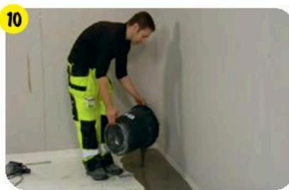
Нанести материал на основание слоем от 25 мм вручную или насосом полосами шириной 6–8 м так, чтобы новая полоса раствора наплынула на предыдущую. Местастыковки полос разровнять зубчатым или гладким шпателем.
