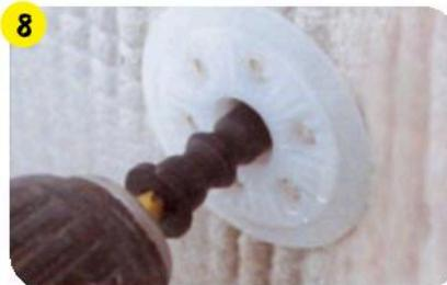
Не дожидаясь затвердевания клеевого раствора, дополнительно зафиксировать теплоизоляционную плиту с помощью фасадных дюбелей (сквозь сетку).
