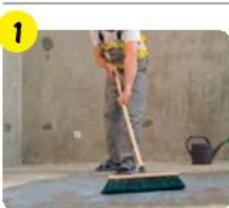
1 Очистить, обеспылить основание и за 4 ч перед нанесением наливного пола обработать грунтовкой **vetonit MD 16 superconcentrate** или **vetonit prim multi universal**, используя щетку. Определить перепады высот. Выставить точечные реперные маячки **weber.floor levell marker** при заливке слоем от 10 мм.
