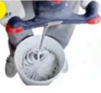
Смешивать дрелью с насадкой в течение 3–5 мин. Для лучшего растворения вяжущего дать отстояться 10 мин. После легкого повторного перемешивания смесь готова к работе. Смесь пригодна для использования в течение 30 ч с момента затворения водой (60 ч при хранении в закрытой таре).
