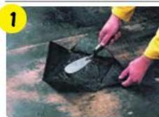
Удаление пузырей и ремонт отслоений. Пузыри на старых рулонных покрытиях кровли крестообразно надрезать, концы отогнуть, пространство пузыря заполнить мастикой weber.tec 911.
