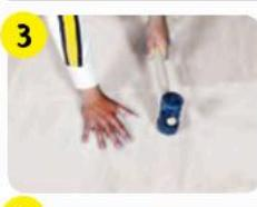
Нанести клей зубчатым шпателем на поверхность, которая может быть облицована в течение 30 мин. Рекомендованная толщина слоя от 1 до 10 мм в зависимости от формата плитки.
