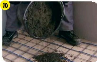
Нанести ровитель **weber.vetonit 6000** на основание и распределить его по поверхности, заполняя пространство между маячными рейками. Придать полу необходимый уклон. Затем разровнять правилом.
