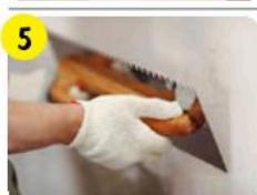
При нанесении нескольких слоев второй слой штукатурки наносится, не дожидаясь полного высыхания первого слоя (через 1–1,5 ч). Потолки штукатурить только в один слой толщиной не более 15 мм.
