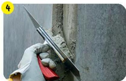
Очистить основание от легко отслаивающихся частей. Сильно поврежденные участки отремонтировать с помощью быстро схватывающегося водонепроницаемого состава **weber.tec 933** или **weber.vetonit S06**.
