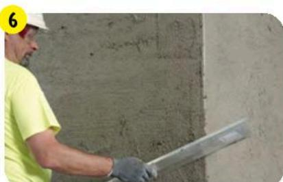
При неровности более 20 мм/м нанести штукатурку **weber.stuk cement winter** слоем от 5 до 30 мм для выравнивания поверхности.
