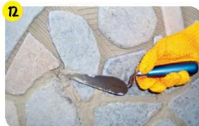
После полного высыхания клеевого раствора, но не ранее чем через 24 часа швы между плитками заполнить с помощью специального шприца-пистолета затиркой **vetonit rapid**. Уплотнить затирку с помощью расшивки для кладочных швов.
