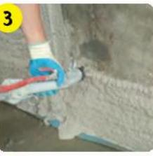
Сопло держать перпендикулярно поверхности. Нанесение рекомендуется начинать с нижней части поверхности. Раствор рекомендуется наносить параллельными полосами, перекрывая предыдущую полосу не менее чем на треть. После нанесения раствора разровнять его Н-образным правилом.
