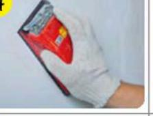
Высохшую поверхность обработать шлифовальной бумагой и обеспылить перед нанесением следующего слоя. Каждый последующий слой наносить на полностью высохший предыдущий (через 1 сут).
