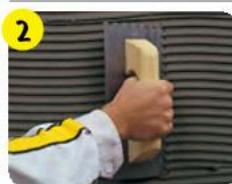
2 Нанести клей зубчатым шпателем на поверхность, которая может быть облицована в течение 15 мин. При укладке плитки на пол или при работе с толстым слоем клеящего состава (10–15 мм) дополнительно нанести клей на обратную сторону плитки.
