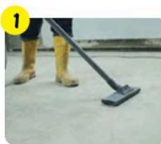
Очистить, обеспылить основание и за 4 ч перед нанесением наливного пола обработать грунтовкой **vetonit MD 16 superconcentrate** или **vetonit prim multi universal**, используя щетку. Определить перепады высот. Выставить точечные реперные маячки **weber.floor level marker** при заливке слоем от 10 мм.
