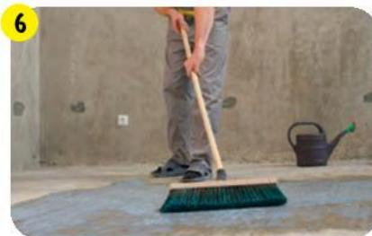
Обработать основание грунтовкой-концентратом **vetonit MD 16 superconcentrate**, разведенной в соответствии с инструкцией на упаковке, либо универсальной грунтовкой **vetonit prim multi universal** без разбавления, используя щетку. Через 4 часа заделать локальные неровности до 8 см быстровъедущим ровнителем **weber.vetonit 5000**. Продолжить работу не ранее чем через 1–5 суток.
