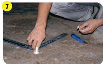
Используя уровень или нивелир, оценить ровность пола, разметить высоты основания и выставить точечные маячки **weber.floor level marker** с шагом 1-1,5 м для контроля толщины слоя материала (при заливке слоем от 10 мм).
