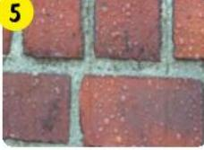
Плотные основания (например, бетонная кровля, глазурованный клинкер) примерно через 2 ч после пропитки промыть водой (губка, тряпка).
