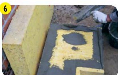
Клеевой раствор наносить по периметру плиты и нескольким точкам по центру (площадь контакта клея с теплоизоляцией должна быть не менее 40 %).
