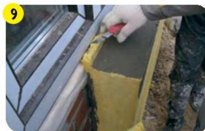
Шов между теплоизоляцией и оконной рамой заполнить клиновидными полосками из той же теплоизоляции или предварительно наклеенной саморасширяющейся уплотнительной лентой.
