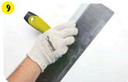
После шлифования и обеспыливания поверхности выполнить финишное выравнивание при помощи супербелой влагостойкой цементной шпаклевки **weber.vetonit VH**.
