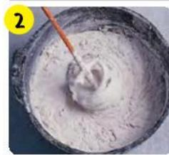
Приготовить раствор согласно инструкции на обратной стороне мешка. Смесь добавить в строго отмеренное количество воды, перемешать до однородной массы без комков, оставить на 5–10 мин и повторно перемешать 1–2 мин. Добавление воды в раствор запрещено, рекомендуется перемешивать в процессе работы.
