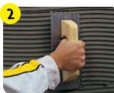
Нанести клей зубчатым шпателем на поверхность, которая может быть облицована в течение 30 мин.
