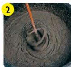
Приготовить раствор согласно инструкции на обратной стороне мешка. Смесь добавить в строго отмеренное количество воды, перемешать до однородной массы без комков, оставить на 5–10 мин и повторно перемешать 1–2 мин. Добавление воды в раствор запрещено, рекомендуется перемешивать в процессе работы.
