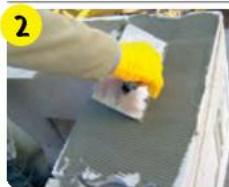
Нанести на основание зубчатым шпателем, размер зубцов зависит от размера блоков: чем больше блок, тем больше зубцы шпателя. Предварительной подготовки блоков не требуется.
