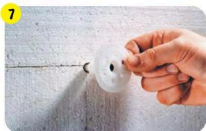
Не ранее чем через 3 суток после приклеивания дополнительно зафиксировать теплоизоляцию с помощью фасадных дюбелей. Шляпки дюбелей утопить в теплоизоляцию на 1-2 мм.
