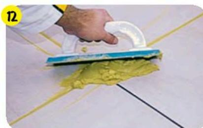
Через 24 часа заполнить швы затиркой **weber.vetonit decor** (швы 1–6 мм) или **vetonit rapid** (швы 2–30 мм).
