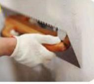
**5** При нанесении нескольких слоев второй слой штукатурки наносится, не дожидаясь полного высыхания первого слоя (через 1–1,5 ч). Потолки штукатурить только в один слой толщиной не более 15 мм.
