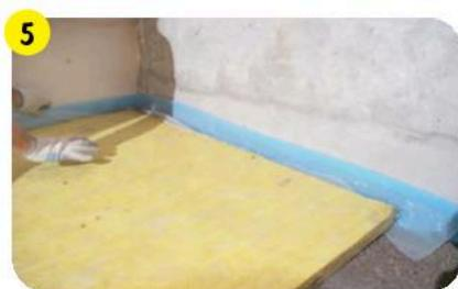
Утеплить выровненное основание теплоизолирующим материалом (минераловатными плитами).
