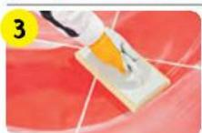
Через 10–20 мин протереть облицованную поверхность влажной губкой для удаления оставшейся затирки и формирования шва.
