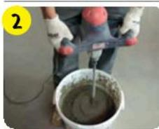
Смешивать при помощи дрели с насадкой в течение 3–5 мин до однородной массы. Дать отстояться раствору в течение 10 мин и еще раз перемешать. Время использования готовой смеси 3 ч с момента затворения водой. Температура использования смеси должна быть в пределах от +5 до +30 °C.
