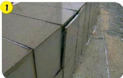
Если цокольная часть испытывает подпор влаги из основания, происходит отрыв облицовки. При ошибках проектирования и производства работ на цоколе облицовка из плитки в течение короткого времени начинает отслаиваться и отваливаться.
