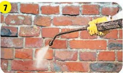
Основание следует очистить от грязи и высолов щеткой, струей воды под давлением или пескоструйной обработкой.
