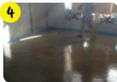
Распределить материал по поверхности широким шпателем, разровнять и загладить.
