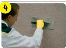
Толщина нанесения примерно в 1,5 раза больше размера зерна. Сразу после нанесения разгладить нанесенную штукатурку при помощи металлического шпателя.
