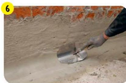
В зоне соединения пола и стены проделать канавку 4 x 4 см для выполнения примыкания с закруглением при помощи безусадочного водоизоляционного раствора **weber.tec 933**.
