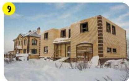
Можно считать цементный раствор достигшим достаточной прочности при замерзании, если кладка затвердела при температуре выше 0°C в течение не менее 2 суток.
