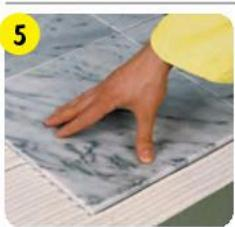
Через 3 ч, когда по полу уже можно ходить, перенести деформационные швы на верхний слой стяжки либо нанести следующий слой наливного пола, предварительно прогрунтовав поверхность. Через 15 ч уложить напольное покрытие, предварительно заполнив швы эластичным материалом для швов.
