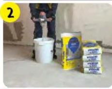
В емкость с 4,5–5 л чистой воды засыпать 25 кг (мешок) **weber.vetonit 4350**. Перемешать дрелью-миксером (400–600 об/мин) до однородной массы (5 мин). Использовать в течение 20–30 мин.
