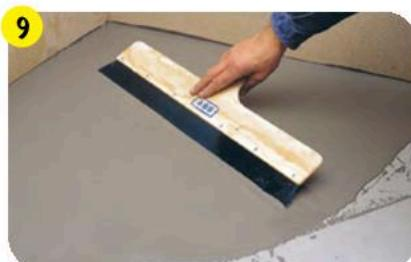
Нанести наливной пол на основание вручную слоем 1–5 мм для **weber.vetonit 3000** или 1–15 мм для **weber.vetonit 3100**. Распределить материал по поверхности основания стальным гладким шпателем или кельмой-мечом, разровнять и загладить.
