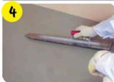
Распределить материал по поверхности стальным гладким шпателем или кельмой-мечом, разровнять и загладить.
