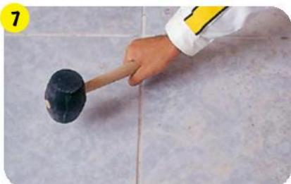
Проверить прочность сцепления старой плитки с основанием, удалить слабо держащуюся плитку.
