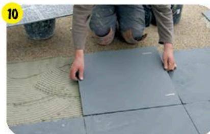
Оставлять межплиточный зазор для компенсации линейных деформаций не менее 2 мм. Клей не должен заполнять шов более чем наполовину.
