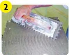
Нанести зубчатым шпателем на поверхность, которая может быть облицована в течение 20 мин.
