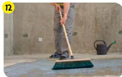
После высыхания слоя через 1–3 суток (в зависимости от толщины стяжки и условий высыхания) обработать поверхность грунтовкой **vetonit MD 16 superconcentrate** или **vetonit prim multi universal** согласно инструкции на упаковке.
