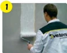
Для повышения прочности сцепления клеевого раствора с основанием перед монтажом теплоизоляции обработать поверхность при помощи грунтовки *vetonit prim facade* без разбавления или *vetonit prim multi universal*, разведенной с водой 1:1.
