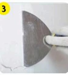
При заделке швов ГКЛ заполнить смесью углубление шва и края соседних плит. Ленту вдавить в шов стальным шпателем шириной 75 мм. Выступающую смесь нанести поверх ленты так, чтобы шов был целиком заполнен. Для полного выравнивания использовать широкий жесткий шпатель. После высыхания швы обработать шлифовальной бумагой.
