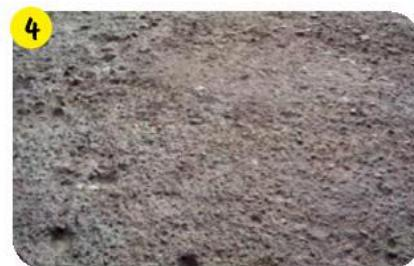
Бетонное основание имеет грубую поверхность, не подходящую для укладки линолеума.
