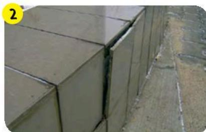
При потеплении приклеенная на холода с помощью обычных цементных kleev облицовка отслаивается.
