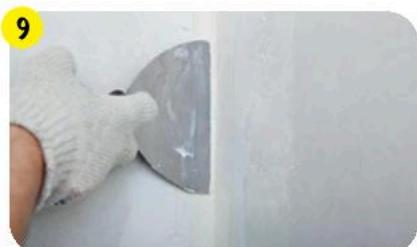
Швы в углах армируются шовной лентой и заполняются большим количеством **weber.vetonit JS**. Ленту согнуть вдоль сгиба на 90° и вдавить шпателем в шов. Выступающую смесь нанести поверх ленты. После этого добавить смесь и выровнять угол.
