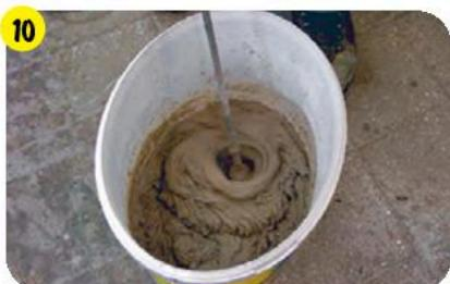
Залить в емкость воду согласно инструкции и засыпать 25 кг **weber.vetonit ultra fix**. Перемешать механическим способом до однородной массы, оставить на 5 минут и потом еще раз перемешать.
