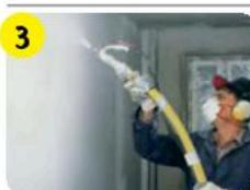
Смесь наносить вручную при помощи стального шпателя или напылять механизированным способом. Предыдущий слой шпаклевки должен высохнуть перед нанесением последующего слоя.
