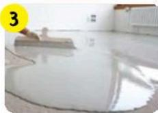
Нанести наливной пол **weber.vetonit 4080** вручную или насосом на основание слоем от 10 до 80 мм.
