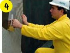
При воздействии воды под давлением сложные узлы можно армировать геоголовком, утопив его во второй слой **weber.tec Superflex 10**.
