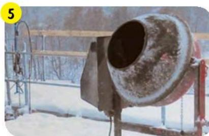
Если кладка в зимних условиях выполняется обычным кладочным раствором, то для его приготовления необходимо использовать теплую воду. В раствор следует добавлять столько теплой воды, чтобы с ним было удобно работать. Если температура сухой смеси, например, -5 °C, то, используя воду температурой +40 °C, можно приготовить раствор с температурой до +10 °C (она должна быть в диапазоне от +5 до +40 °C).
