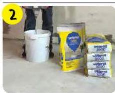
В емкость с 5,2–5,6 л чистой воды засыпать 20 кг (мешок) **weber.vetonit 3000**. Перемешать дределью-миксером (400–600 об/мин) до однородной массы (1–2 мин). Использовать в течение 30 мин.
