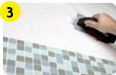
**3** Корректировать положение плитки и мозаики можно до 25 мин после укладки (в зависимости от толщины слоя и температуры помещения).
