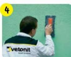
Сразу после нанесения, не допускать обветривания поверхности, создать фактуру, затирая пластиковой гладилкой. Излишки связующего, образующиеся на рабочей поверхности терки, периодически удалять, но не возвращать обратно в ведро с материалом.
