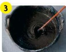
Приготовление водонепроницаемого битумного раствора для стен в подземном строительстве: смешать по объему 1 часть цемента, 2,5 части песка фракций от 0 до 4 мм и добавить в воду, в которую предварительно добавлено от 5 до 20 % weber.tec 901 (в зависимости от давления грунтовых вод), с тем, чтобы получить раствор пластичной консистенции.
