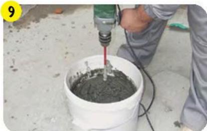
В емкость с 1,8 л чистой воды засыпать 25 кг **weber.vetonit 6000**. Перемешатьдрелью-миксером (400–600 об/мин) до однородной массы (1–2 мин). Смесь добавлять в воду, а не наоборот. Раствор использовать в течение 30 минут. При больших объемах работ для смешивания рекомендуется использовать проточный миксер (например, m-tec D 30, D 50).
