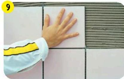
Укладывать плитку можно после полного высыхания гидроизоляционного покрытия (примерно через 24 часа).
