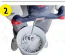
Смешивать дрелью с насадкой в течение 3–5 мин. Дать раствору отстояться 10 мин. После этого еще раз перемешать смесь перед использованием. Время использования готовой смеси 1,5 ч с момента затворения водой (для смеси weber.vetonit VH Grey – 3 ч с момента затворения).
