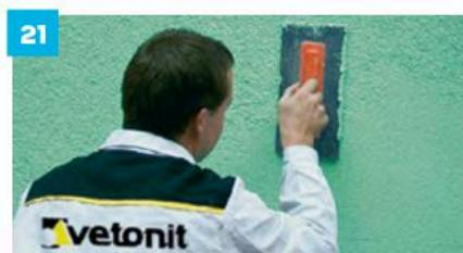
Фактуру создать путем затирки пластиковой теркой сразу после нанесения, не допуская обветривания поверхности.
