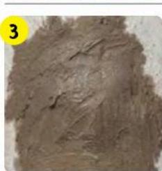
Для эффективной изоляции трещин, глубина которых в 3–4 раза превышает их ширину, достаточно легкого увлажнения. Прочие трещины следует довести до указанной пропорции. При использовании материала в качестве выравнивающей шпаклевки нанести на всю поверхность шпателем из нержавеющей стали, а затем обработать влажной кистью.
