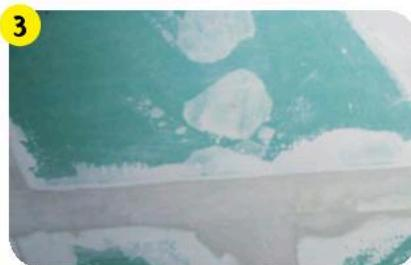
3 Мелкие дефекты на поверхности гипсостроительных плит требуют устранения.
