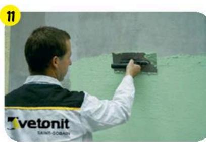
Через 24 часа после нанесения грунтовки нанести декоративную штукатурку при помощи шпателя из нержавеющей стали.
