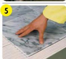
Через 24 ч перенести деформационные швы на верхний слой стяжки либо нанести следующий слой наливного пола, предварительно прогрунтовав поверхность. Через 1–7 нед уложить напольное покрытие, предварительно заполнив швы эластичным материалом для швов.
