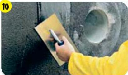
Для герметизации вывода труб и коммуникаций использовать специальные закладные уплотнительные элементы, фланцы которых обработать **weber.tec Superflex 10**.
