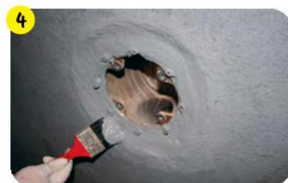
Дать конструкции как следует высохнуть, чтобы произошла усадка бетона. Смыть соли, пропустившие на поверхности бетона при его высыхании. При монтаже в бассейне осветительных приборов и устройстве отверстий строго соблюдать указания по проведению работ.
