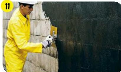
Чтобы заполнить поры и мелкие неровности, после высыхания грунтовки зашпаклевать поверхность с помощью **weber.tec Superflex 10** на сидир.
