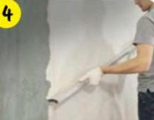
Как только штукатурный раствор начнет схватываться (примерно через 90 мин после затворения), поверхность выровнять металлической трапециoidalной рейкой или широким шпателем, срезая излишки и заполняя углубления.
