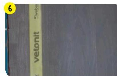
Участки с поврежденной поверхностью бетона отремонтировать с помощью **weber.tec 933**. Укрепить углы, укладывая по вертикали и по горизонтали гидроизоляционные ленты **weber.tec 828 DB 75** или **weber.tec 828 DB 150**, фиксируя их при помощи **weber.tec 824**.
