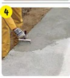
После нанесения **weber.tec 930** поверхность поддерживать во влажном состоянии в течение 24 ч, а в течение последующих 5 сут защищать от прямого воздействия солнечных лучей и отрицательных температур. Защитные слои, краску, плитку, раствор, не содержащий гипса, наносить только после достаточного затвердевания гидроизоляции.
