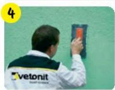
Сразу после нанесения, не допуская обветривания поверхности, создать фактуру, затирая пластиковой гладилкой. Излишки связующего, образующиеся на рабочей поверхности терки, периодически удалять, но не возвращать обратно в ведро с материалом.
