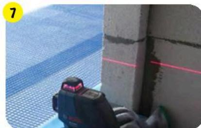
С помощью уровня или нивелира оценить ровность и горизонтальность пола, разметить высоты основания. Выставить точечные маяки **weber.floor level marker** при слое от 10 мм.
