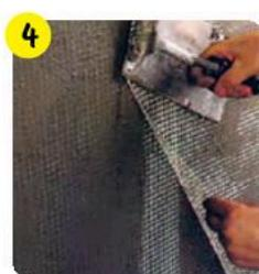
Для создания базового штукатурного слоя, армированного фасадной щелочестойкой сеткой (например, *weber.therm 2000*), на поверхность теплоизоляции зубчатым шпателем нанести клеевой раствор, в который утопить сетку так, чтобы она находилась в верхней трети раствора и была им покрыта не менее чем на 1 мм на рядовых участках и не менее чем на 0,5 мм в местах нахлеста. Разгладить гладкой стороной шпателя.
