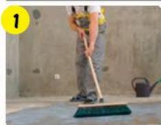
1 Очистить, обеспылить основание и за 4 ч перед нанесением наливного пола обработать грунтовкой **vetonit MD 16 superconcentrate**, используя щетку. Определить перепады высот.
