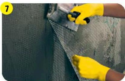
На поверхность нанести клеевой раствор **weber.therm S100**, утопив в него фасадную щелочестойкую сетку **weber.therm 2000**, укладывая ее сверху вниз с минимальным перекрытием на краях в 100 мм, вдавливая гладилкой из нержавеющей стали от центра к краям на глубину ~1/3 от толщины слоя.
