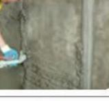
Смесь наносить механизированным напылением или стальным шпателем. Каждый последующий слой наносить на схватившийся предыдущий (через 1–2 сут). Высохшую поверхность обработать шлифовальной бумагой и обеспылить перед нанесением следующего слоя.
