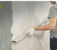
**4** Как только штукатурный раствор начнет схватываться (примерно через 60 мин после затворения), поверхность выровнять металлической трапецидальной рейкой или широким шпателем, срезая излишки и заполняя углубления.
