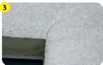
В углах, не усиленных дополнительной сеткой, появляются трещины
