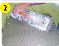
Нанести зубчатым шпателем на поверхность, которая может быть облицована в течение 20 мин. При укладке керамогранита на полы или снаружи помещений нанести клей не только на основание, но и на обратную сторону плитки.
