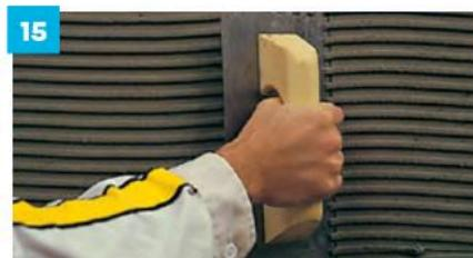
Наповерхность утеплителя нанести раствор weber.therm S100. В него утопить армирующую стекловолоконную сетку (рулон разворачивать сверху вниз) и одновременно вдавливать гладилкой из нержавеющей стали от центра к краям на глубину примерно 1/3 от толщины слоя раствора.
