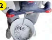
Дать раствору отстояться 10 мин и еще раз перемешать. Смесь пригодна для использования до 24 ч с момента затворения водой (до 3 сут в закрытой таре).
