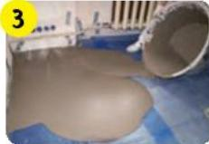
Нанести наливной пол **weber.vetonit 4350** вручную или насосом на основание слоем от 10 до 50 мм.
