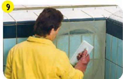
После высыхания клея для затирки межплиточных швов использовать эпоксидный состав.
