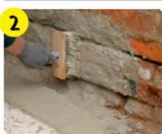
Нанести гидроизоляцию не менее чем за 2 рабочих цикла на увлажненную поверхность шпателем. Первый слой наносится на «стир», последующие слои через 3–4 часа после предыдущего. При давлении воды, обработке емкостей для воды — за 3 рабочих цикла, по всей площади.
