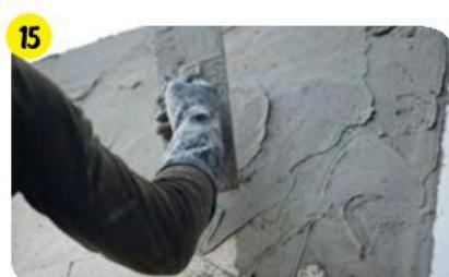
После высыхания гидроизоляции по всей площади стены нанести финишное покрытие **weber.vetonit TT40**.
