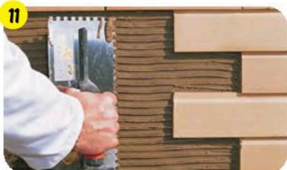
С помощью эластичного усиленного плиточного клея **weber.vetonit ultra fix** или **weber.vetonit ultra fix winter** приклеить облицовку.
