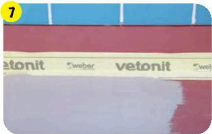
На всю изолируемую поверхность в 2 слоя нанести **weber.tec 822**. Время высыхания между нанесениями 2–4 часа, общая толщина слоев после высыхания – не менее 0,5 мм.
