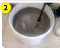
В емкость с 5,2–5,4 л чистой воды засыпать 20 кг (мешок) **weber.vetonit fast 4000**. Перемешать дрелью-миксером (400–600 об/мин) до однородной массы (3–4 мин). Использовать в течение 30 мин.
