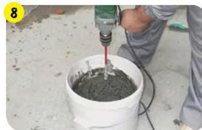
Залить в емкость чистую воду согласно инструкции и засыпать 25 кг **weber.vetonit ultra fix winter**. Перемешать, оставить на 5 минут и повторно перемешать. Если смесь быстро загустевает, периодически перемешивать мастерком или шпателем. Не добавлять воду в готовый раствор.
