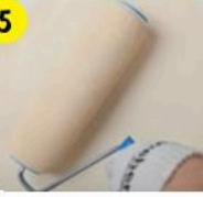
Затвердевшая поверхность готова к покраске или оклейке обоями только после полного высыхания шпаклевочного слоя. После высыхания зашлифуйте поверхность.
