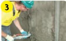
Смесь наносить механизированным напылением или стальным шпателем. Каждый последующий слой наносить на высохший предыдущий (через 1–2 сут). Высохшую поверхность обработать шлифовальной бумагой и обеспылить перед нанесением следующего слоя.
