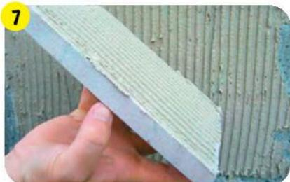
Клей следует наносить как на основание, так и на тыльную сторону облицовки для обеспечения 100%-ного контакта и заполнения пространства под плиткой kleem.
