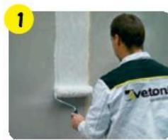
Основания не должны подвергаться усадке или деформации. Неровности ( $\geq 2 \text{ мм/м}$ ) необходимо выровнять с помощью подходящего материала (например, **weber.stuk cement**, **weber.vetonit 414** или **weber.render facade**).
