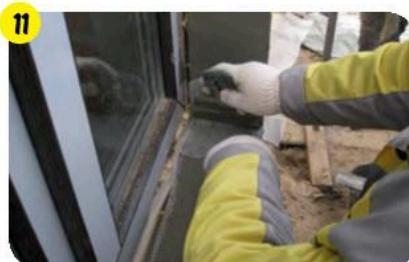
Внутренние углы оконного проема дополнительно армировать полоской сетки, утопив ее в клеевой раствор и разгладив.
