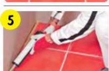
Для заполнения деформационных швов применять заполнитель/герметик на полиуретановой основе. Для стыков «стена – стена» и «стена – пол» на внутренней облицовке применять силиконовые герметики.
