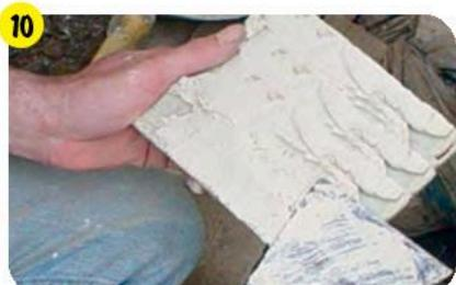
При помощи зубчатого шпателя на загрунтованный армированный слой и обратную сторону плитки нанести клеевой раствор **weber.vetonit ultra fix**. Плитку плотно прижать к основанию.
