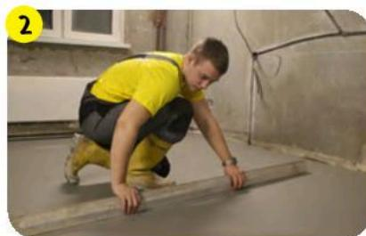
Основание имеет отклонения от горизонта более 2 мм на двухметровом правиле.
