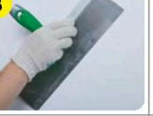
Смесь наносить вручную при помощи стального шпателя или напылять mechanized способом. Предыдущий слой шпаклевки должен высохнуть перед нанесением последующего слоя.
