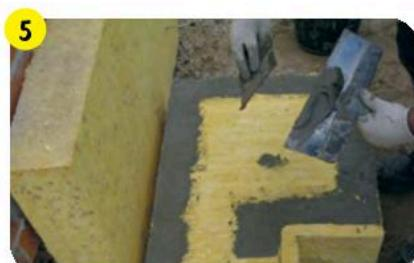
Места, на которые наносится клей, загрунтовать тонким слоем kleевого раствора **weber.therm MW** или **weber.therm S100**.
