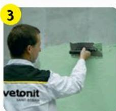
Шпателем (гладилкой) из нержавеющей стали наносить штукатурку на загрунтованную поверхность на толщину, равную размеру зерна при рифленой фактуре («короед») и 1,5-кратному размеру зерна — при зернистой («шуба»). Стыковать участки нанесения штукатурки следует «по-живому», до начала ее высыхания.
