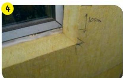
Теплоизоляцию для монтирования вокруг оконных и дверных проемов вырезать из цельной плиты T-образные стыки в углах недопустимы.
