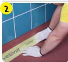
Углы, компенсационные, стыковые и подвижные швы, зоны перехода материалов изолировать эластичной водонепроницаемой лентой **weber.tec 828 DB 75**, приклеенной с помощью **weber.tec 822**. Для гидроизоляции мест входа труб изготовить манжеты из ленты.
