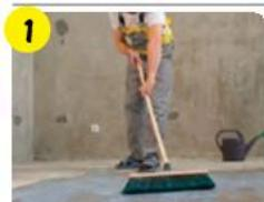
1 Очистить, обсыпать основание и за 4 ч перед нанесением наливного пола обработать грунтовкой **vetonit MD 16 superconcentrate** или **vetonit prim multi universal**, используя щетку. Определить перепады высот.
