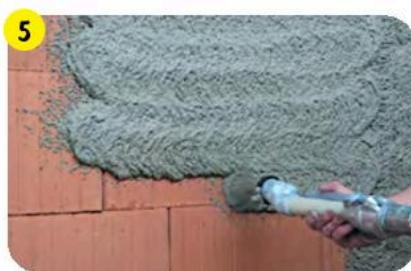
Приготовить раствор согласно инструкции на обратной стороне мешка (при ручном нанесении штукатурки) или в штукатурной станции (при машинном нанесении).
