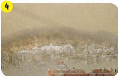
Плохая гидроизоляция фундамента вызывает подсос влаги из почвы, происходит разрушение штукатурки.
