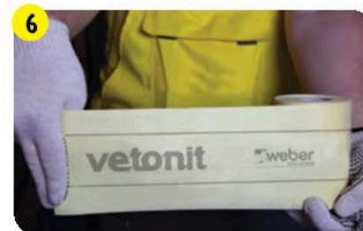
Формировать углы при помощи ленты **weber.tec 828 DB 75** или **DB 150**. Для гидроизоляции точек подключения сантехнического оборудования изготовить манжеты из ленты.
