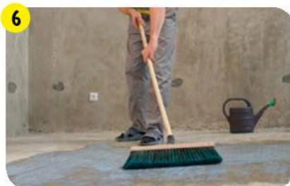
Обработать основание грунтовкой-концентратом **vetonit MD 16 superconcentrate**, разведенной в соответствии с инструкцией на упаковке, либо универсальной грунтовкой **vetonit prim multi universal** без разведения, используя щетку.
