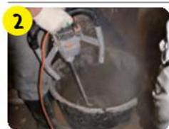
2 В емкость с 4,8–5,2 л чистой воды засыпать 20 кг (мешок) **weber.vetonit 3100**. Перемешать дрелью-миксером (400–600 об/мин) до однородной массы (1–2 мин). Использовать в течение 30 мин.
