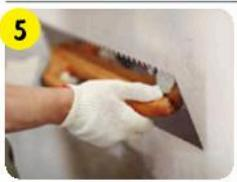
При нанесении нескольких слоев второй слой штукатурки наносится, не дожидаясь полного высыхания первого слоя (через 1–1,5 ч). Потолки штукатурить только в один слой толщиной не более 15 мм.
