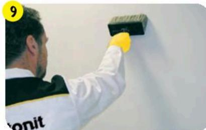
Не ранее чем через 5 суток поверхность армированного слоя обработать грунтовкой **vetonit prim multi universal**, разведенной с водой 1:1.
