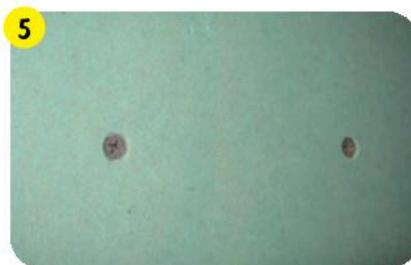
5 На поверхностях гипсостроительных плит проверить, не выступают ли шляпки саморезов за плоскость картона. При необходимости закрутить.
