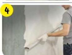
Как только штукатурный раствор начнет схватываться (примерно через 60 мин после затворения), поверхность выровнять металлической трапециoidalной рейкой или широким шпателем, срезая излишки и заполняя углубления.
