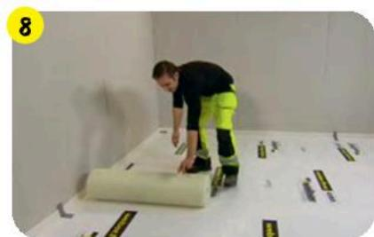
Для контроля толщины стяжки выставить маячки **weber.floor level marker**. Уложить на основание стекловолоконную сетку **weber.floor 145** с перекрытием полос  $\geq 10$  см.
