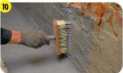
Создать гидроизоляционный слой с помощью обмазочной эластичной гидроизоляции **weber.tec 824** или **weber.tec 930** (для недеформирующихся оснований).
