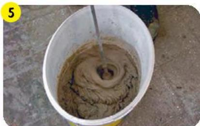
Залить в емкость воду согласно инструкции и засыпать мешок **weber.vetonit granit fix** / **vetonit comfort power fix**. Перемешать механическим способом до однородной массы, оставить на 5 минут и еще раз перемешать.
