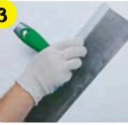
Смесь наносить вручную при помощи стального шпателя или напылять механизированным способом. Предыдущий слой шпаклевки должен высохнуть перед нанесением последующего слоя.
