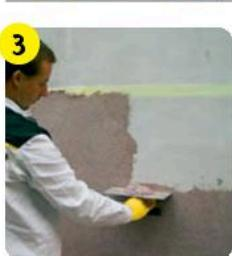
Шпателем (гладилкой) из нержавеющей стали наносить штукатурку на загрунтованную поверхность на толщину, равную размеру зерна. Стыковать участки нанесения штукатурки следует «по-живому», до начала ее высыхания. Необходимо следить за тем, чтобы стыки штукатурок всегда притирались в сыром состоянии и использовались одинаковые штукатурные терки.
