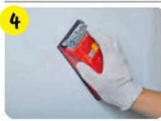
Рабочие швы и поверхность зашлифовать после достаточного высыхания смеси через 1–2 сут. Шпаклевка достигает окончательной прочности в течение 4 недель.
