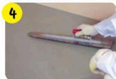
4 Распределить материал по поверхности стальным гладким шпателем или кельмой-мечом, разровнять и загладить. При необходимости можно использовать игольчатый валик.
