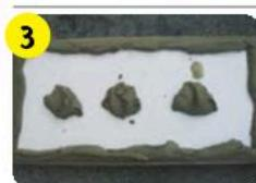
При монтаже теплоизоляции клеевой раствор наносить по периметру плиты и на несколько точек по центру плиты. Площадь приклейивания должна составлять не менее 40 %.
