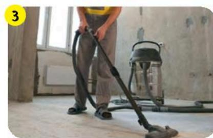
Рекомендуется тщательно очистить поверхность от пыли и прогрунтовать **vetonit prim multi universal**. Плохая подготовка поверхности перед облицовкой препятствует прочному сцеплению клея с основанием.
