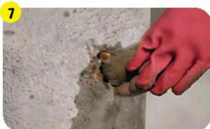
При возникновении течи в стене воду можно остановить при помощи раствора для устранения течей **weber.tec 935** (гидропломбы).
