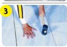
Корректировать положение плитки можно в течение 20 мин после укладки. Вдавливать плитку в клей с усилием. Клей не должен заполнять шов более чем наполовину.
