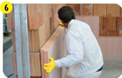
После высыхания гидроизоляции (не ранее чем через 24 часа для **weber.tec 824** и не ранее чем через 5 суток для **weber.tec 930**) приклеить с помощью клея **weber.therm S100** на основание теплоизоляцию из экструдированного пенополистирола.
