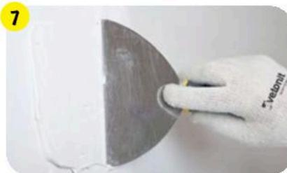
Шовную ленту вдавить в шов стальным шпателем. Выступающую смесь нанести поверх ленты. Добавить смесь на ленту так, чтобы шов был полностью заполнен.
