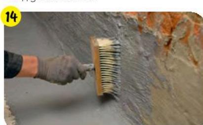
В качестве гидроизоляции нанести 2 слоя **weber.tec 824** или **weber.tec 930** (при воздействии воды под давлением – 3 слоя).
