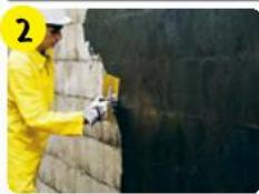
Для закрытия пор, небольших углублений, открытых швов шириной до 5 мм произвести шпаклевку всей поверхности **weber.tec Superflex 10** на сидир.
