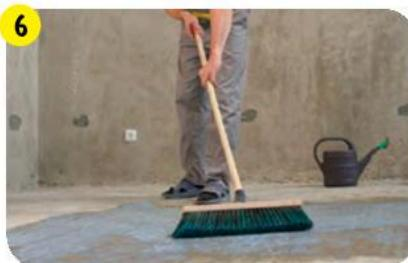
Обработать основание грунтовкой-концентратом **vetonit MD 16 superconcentrate**, разведенной в соответствии с инструкцией на упаковке, либо универсальной грунтовкой **vetonit prim multi universal** без разбавления, используя щетку.
