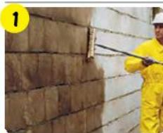
Применение в качестве грунтовки: weber.tec 901 разбавить водой в соотношении 1:10 по объему и наносить на подготовленную поверхность.
