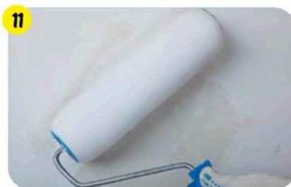
Перед покраской поверхность рекомендуется обработать при помощи грунтовки **vetonit prim multi universal**, разведенной водой 1:1
