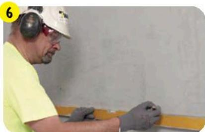
Разметить поверхность под установку крепежа, который должен располагаться с шагом 40–50 см по горизонтали и вертикали.
