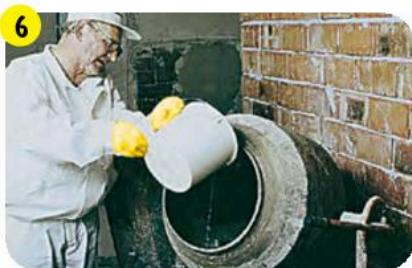
Приготовленный раствор не должен оставаться слишком быстро до завершения кладки. Поэтому готовить его следует небольшими порциями, можно использовать термоизоляционное покрытие или излучающий обогреватель. Если раствор слишком остывает, вернуть его в мешалку и смешать с новой теплой порцией раствора. Нужно учесть, что время работы с теплым раствором сокращается. Рекомендации по выбору температуры воды приведены в таблице на стр. 87.
