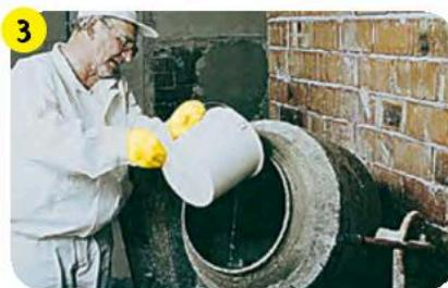
Сухую смесь перемешать в бетономешалке (6–8 мин) или дрелью-миксером (4–5 мин) с чистой водой, количество которой указано в техническом описании или на мешке. Готовый раствор пригоден для использования 2 часа с момента затворения.
