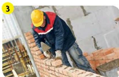
Чтобы цементный раствор набрал достаточную прочность, кладка должна затвердеть при температуре выше 0 °C в течение не менее 2 суток.
