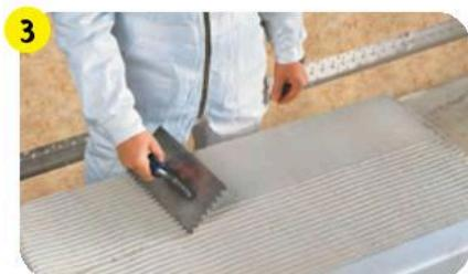
Клей наносить на всю поверхность теплоизоляционной плиты при помощи зубчатого шпателя.
