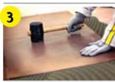
Корректировать положение плитки можно в течение 25 мин после укладки.
