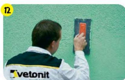
**12** Спустя 7 суток после нанесения выравнивающего слоя произвести декоративно-защитную отделку при помощи **vetonit prim uni** и одной из следующих штукатурок: **weber.pas extraClean, weber.pas silikon**.
