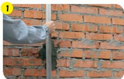
1 Отклонение стены от вертикальной плоскости превышает допустимые значения.
