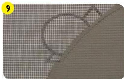
Создать армированный слой, утопив внутрь клеевого раствора фасадную щелочестойкую сетку **weber.therm 2600**.
