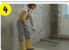
4 Распределить материал по поверхности широким шпателем, разровнять и загладить. При необходимости можно использовать игольчатый валик.
