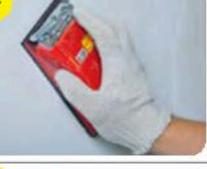
Высохшую поверхность обработать шлифовальной бумагой и обеспылить перед нанесением следующего слоя. Каждый последующий слой наносить на полностью высохший предыдущий (через 1–2 сут).
