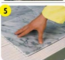
5 Через 3–4 ч, когда по полу можно ходить, перенести деформационные швы на верхний слой стяжки либо нанести следующий слой напливного пола (через 24 ч). Через 1–5 сут уложить напольное покрытие, предварительно заполнив швы эластичным материалом для швов.
