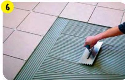
Клей необходимо наносить как на основание, так и на обратную сторону плитки (обеспечивая 100%-ный контакт клея с основанием и плиткой).
