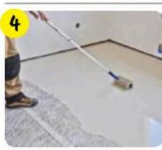
Распределить материал по поверхности широким шпателем, разровнять и загладить. При необходимости можно использовать игольчатый валик либо всю поверхность пола простукивать трубой, деревянным бруском или метровым правилом, закрепленными на палке.
