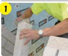
Расшивка швов на готовых поверхностях производится во время кладки. Кладка выполняется в полный шов, швы уплотняются и формируются при помощи расшивки или иного аналогичного инструмента обычно в течение нескольких минут после кладки.
