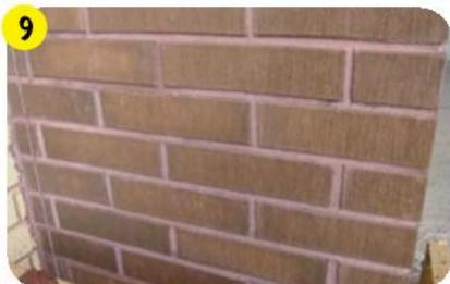
Кладочный раствор **weber.vetonit ML5** может применяться для кладки клинкерного кирпича с водопоглощением 4–6 %. В связи с низким водопоглощением данного кирпича скорость схватывания раствора может незначительно снижаться.
