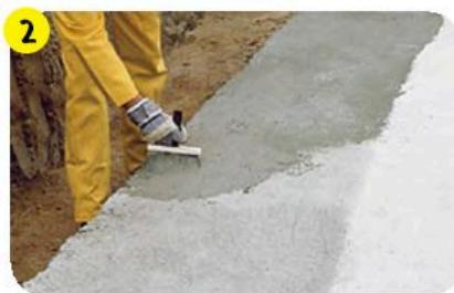
Перед началом работ по кладке нанести 2 слоя гидроизоляции при помощи эластичного цементного раствора **weber.tec 824**.
