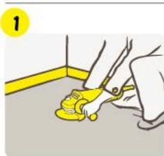
Старые покрытия, загрязнения, органические вещества и пыль необходимо удалить, используя шлифовальную машину. Необходимо тщательно очищать поверхность от масляных загрязнений. Возможные неровности поверхности следует сгладить. Необходимо тщательно удалять все свободные частицы и шлифовальную пыль с поверхности.
