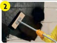
Применение в качестве изоляционного и защитного покрытия: после высыхания грунтующего слоя нанести 1–2 слоя без разбавления водой.
