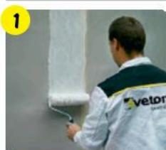
За 24 ч до нанесения декоративной штукатурки поверхность грунтуется с помощью тонирующей грунтовки **vetonit prim uni**.
