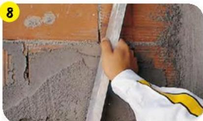
Если неровность основания составляет более 15 мм, то его следует предварительно оштукатурить цементной водостойкой штукатуркой **weber.vetonit TT40**. Последующие слои наносить не ранее чем через 1 неделю на каждый сантиметр слоя.
