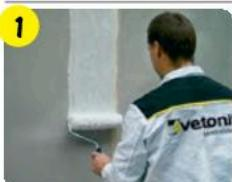
Сильно впитывающие и мелящие основания рекомендуется предварительно обработать грунтовкой **vetonit prim facade** без разбавления или **vetonit prim multi universal**, разведенной с водой 1:1.
