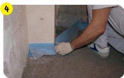
По периметру балкона уложить демпферную ленту (из тепло-/звукозоляционного материала) на высоте  $\geq 10$  см от поверхности пола до верхнего края напольного покрытия.
