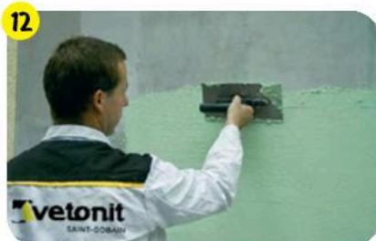
После высыхания грунтовки (через 24 часа) на поверхность армированного слоя нанести защитно-декоративное покрытие **weber.pas silikon**.
