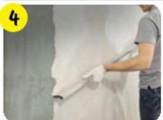
Как только штукатурный раствор начнет схватываться (примерно через 60 мин после затворения), поверхность выровнять металлической трапециoidalной рейкой или широким шпателем, срезая излишки и заполняя углубления.
