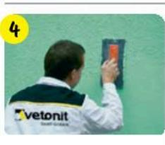
Сразу после нанесения, не допуская обветривания поверхности, создать фактуру, затирая пластиковой гладилкой. Излишки связующего, образующиеся на рабочей поверхности терки, периодически удалять, но не возвращать обратно в ведро с материалом.
