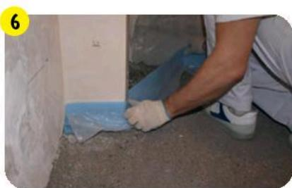
По периметру помещения и вокруг проходов установить демперную ленту на высоте  $\geq 10$  см от поверхности пола до верхнего края напольного покрытия.
