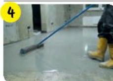
Распределить материал по поверхности широким шпателем, разровнять и загладить. При необходимости можно использовать игольчатый валик.
