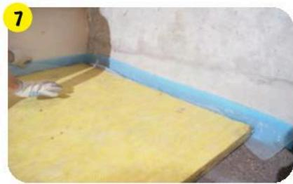
Утеплить выровненное основание теплоизолирующим материалом (пено-полистирольными или минераловатными плитами).
