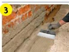
В качестве сцепляющего слоя на старую кладку нанести при помощи зубчатого шпателя.
