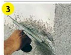
На загрунтованную поверхность шпателем (гладилкой) из нержавеющей стали нанести слой штукатурки толщиной, равной размеру зерна. Стыковать участки нанесения штукатурки «по-живому», т. е. до того, как она начнет высыхать.
