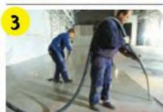
3 Нанести наливной пол **weber.vetonit 4615** вручную или насосом на основание слоем от 8 до 25 мм. Оптимальный рабочий слой – 8–10 мм.
