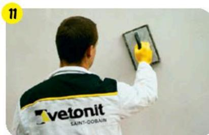
Не дожидаясь обветривания поверхности, создать фактуру, затирая поверхность пластиковой теркой. Спустя 3–5 суток поверхность можно красить.
