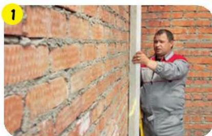
Применение некачественного раствора для кладки не обеспечивает равномерность шва по толщине и вертикальность стены, а также соответствие эстетическим требованиям.
