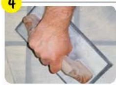
При укладке керамогранита на полы или снаружи помещений нанести клей не только на основание, но и на обратную сторону плитки. Рабочий слой составляет от 2 до 20 мм.
