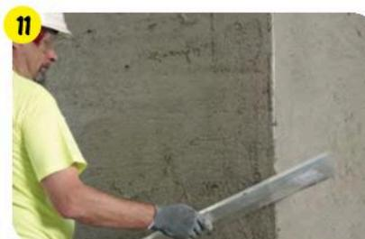
**11** Спустя 24 часа увлажнить поверхность базового штукатурного слоя водой так, чтобы он сохранил абсорбирующую способность, и нанести выравнивающий слой штукатурки **weber.vetonit 414**. В течение 2-3 суток поддерживать поверхность слегка влажной.
