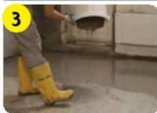
Нанести наливной пол **weber.vetonit 3000** вручную на основание слоем от 1 до 5 мм.
