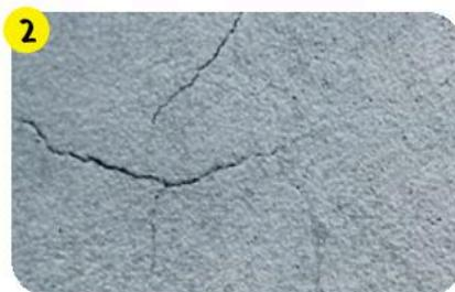
Если прочность основания меньше прочности штукатурки, то на поверхности штукатурного слоя могут образовываться трещины.
