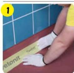
Лента приклеивается с помощью соответствующего гидроизоляционного материала weber (например, **weber.tec 822** или **weber.tec 824**). В свеженанесенный слой гидроизоляционного материала вдавливается гидроизоляционная лента. При ее наклеивании следует избегать растяжений и перекосов.
