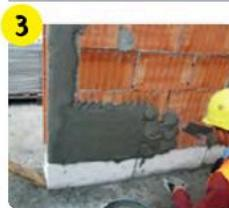
Раствор наносить стальным шпателем или набрасывая кельмой до нужной толщины слоя (5–30 мм). При толщине слоя более 30 мм рекомендуется армировать раствор штукатурной щелочестойкой сеткой.
