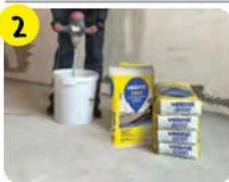
2 В емкость с 3–3,5 л чистой воды засыпать 25 кг (мешок) **weber.vetonit 5000**. Перемешать дрелью-миксером (400–600 об/мин) до однородной массы (1–2 мин). Смесь добавлять в воду, а не наоборот. Использовать в течение 30 мин.
