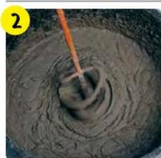
Приготовить раствор согласно инструкции на обратной стороне мешка. Смесь добавить в строго отмеренное количество воды, перемешать до однородной массы без комков, оставить на 5–10 мин и повторно перемешать 1–2 мин. Добавление воды в раствор запрещено, рекомендуется перемешивать в процессе работы.
