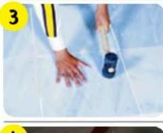
Корректировать положение плит можно в течение 25 мин после укладки.
