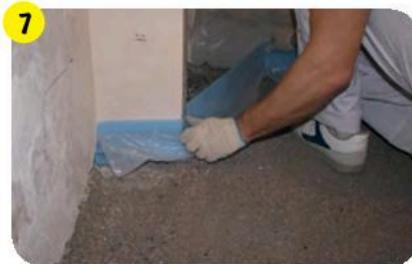
По периметру помещения и вокруг проходов укрепить демпферную ленту на высоте  $\geq 10$  см от поверхности пола до верхнего края напольного покрытия.
