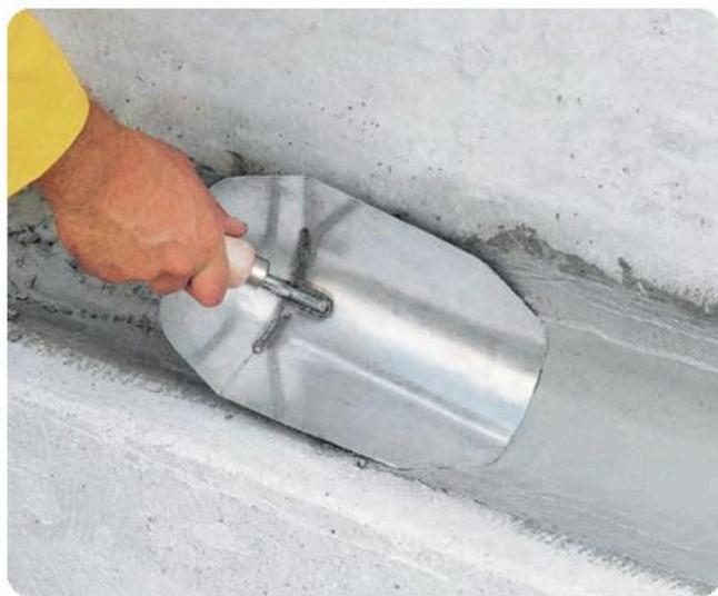
**weber.tec 933** применяется в качестве вспомогательного материала при устройстве гидроизоляции подвалов, фундаментов, резервуаров, бассейнов внутри и снаружи помещений. Может наноситься на бетон, цементный пол, кирпичную и известковую кладку. После затвердевания на него можно наносить гидроизоляционные материалы, например битумные или минеральные покрытия.
