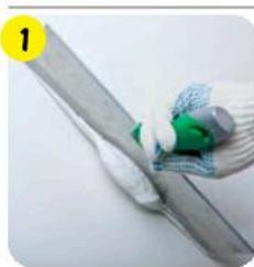
Основание должно быть чистым и твердым. Температура основания и смеси должна быть не менее +10 °C. Для выравнивания больших поверхностей рекомендуется использовать стальной шпатель шириной до 80 см. Время высыхания составляет приблизительно 3–12 ч в зависимости от условий высыхания.
