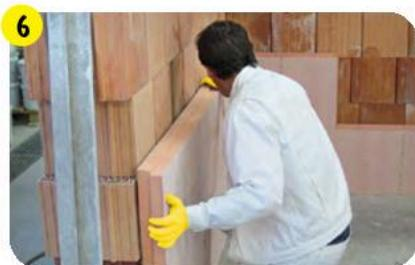
После высыхания гидроизоляции (не ранее чем через 24 часа для **weber.tec 824** и не ранее чем через 5 суток для **weber.tec 930**) прикрепить с помощью клея **weber.therm S100** на основание теплоизоляцию из экструдированного пенополистирола.
