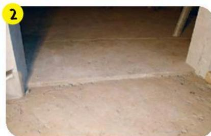
Бетонное основание имеет значительные неровности, недопустимые при укладке линолеума.
