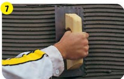
Равномерно нанести клей на основание зубчатым шпателем.
