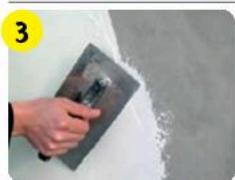
Раствор наносить стальным шпателем или набрасывая кельмой до нужной толщины слоя (1–4 мм).
