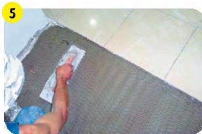
Обычные цементные смеси при низких, но положительных температурах (близких к +5 °C) малопластичны, трудно наносятся и не позволяют корректировать плитку.
