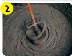
Приготовить раствор согласно инструкции на обратной стороне мешка. Смесь добавить в строго отмеренное количество воды, перемешать до однородной массы без комков, оставить на 5–10 мин и повторно перемешать 1–2 мин.
