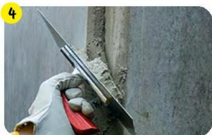
Очистить основание от легко отслаивающихся частей. Сильно поврежденные участки отремонтировать с помощью быстро схватывающегося водонепроницаемого состава **weber.tec 933**.
