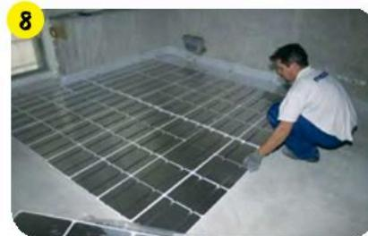
Утеплить выровненное основание теплоотражающим материалом (например, фольгированными пенополистирольными плитами). Уложить элементы теплого пола, дополнительно армировав стяжку сеткой.
