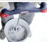
**2** Мешок (30 кг) сухой смеси постепенно высыпать в емкость с 13,5–16,5 л чистой воды при перемешивании. Рекомендуемая температура воды +10 °C. Смешивать дрелью с насадкой в течение 1–3 мин до получения однородной консистенции.
