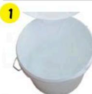
Основание должно быть чистым, твердым и прочным. Температура основания и растворной смеси должна быть не менее +10 °C. Мешок (20 кг) сухой смеси постепенно высыпать в емкость с 6,4–7,6 л воды (см. расход воды в таблице в зависимости от продукта), одновременно перемешивая.
