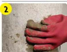
В случае повреждений небольшой площади засыпать сухой **weber.tec 935** в щели, удерживая его мокрой кистью до полного затвердевания.
