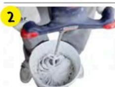
Мешок (30 кг) сухой смеси постепенно высыпать в емкость с 13,5–16,5 л чистой воды при перемешивании. Рекомендуемая температура воды +10 °C. Смешивать дрелью с насадкой в течение 1–3 мин до получения однородной консистенции.
