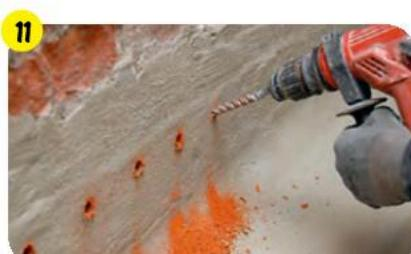
Перед инъекцией материала **weber.tec 940E** в зоне проведения работ нанести **weber.tec 933** для предотвращения потери давления. В кладке проделать отверстия на расстоянии 10–12 см друг от друга под углом 35–45°.
