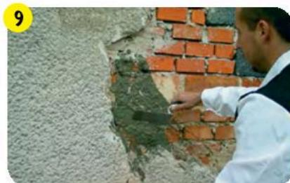
Слегка смочить стену водой и нанести первый слой штукатурки **weber.stuk cement** или **weber.vetonit 414**. Если толщина выравнивающего слоя более 30 мм, через 24 часа нанести 2-й слой.
