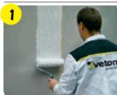
Сильно впитывающие и мелющие основания рекомендуется предварительно обработать грунтовкой **vetonit prim facade** без разбавления или **vetonit prim multi universal**, разведенной с водой 1:1.
