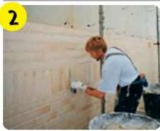
При работе со светлыми растворами следует использовать пластиковую либо деревянную расшивку, так как металлическая расшивка может изменить цвет раствора.
