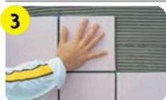
3 Корректировать положение плитки можно в течение 20 мин после укладки.
