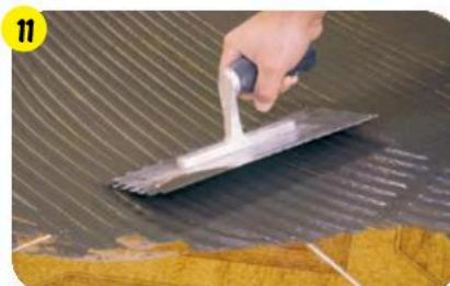
Равномерно нанести клей на основание зубчатым шпателем и уложить плитку, слегка вдавливая ее в слой клея.
