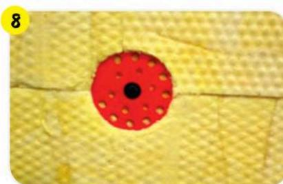
Не ранее чем через 24-48 часов после монтажа дополнительно зафиксировать теплоизоляцию при помощи фасадных тарельчатых дюбелей.
