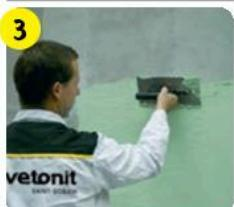
Штукатурку необходимо наносить на основание при помощи гладилки из нержавеющей стали. Толщина нанесения должна составлять 1,5 размера зерна. Стыки необходимо притирать в сыром состоянии.
