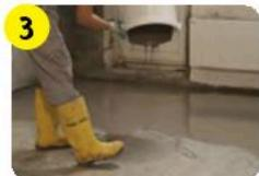
3 Нанести наливной пол **weber.vetonit 3100** вручную на основание слоем от 1 до 15 мм.
