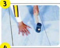
Корректировать положение плитки можно в течение 20 мин после укладки.
