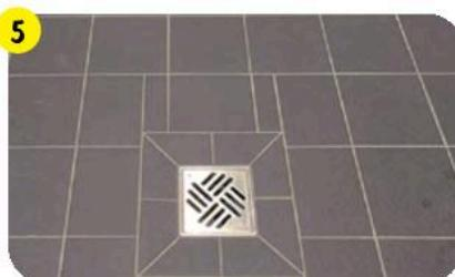
Требуется придать полу определенный уклон и смонтировать спливной водосток (в ванной комнате).
