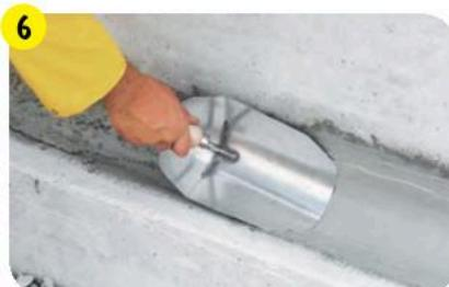
Нанесение **weber.tec 933** исключит появление внутреннего угла 90° и обеспечит последующее равномерное нанесение слоя гидроизоляционного покрытия.
