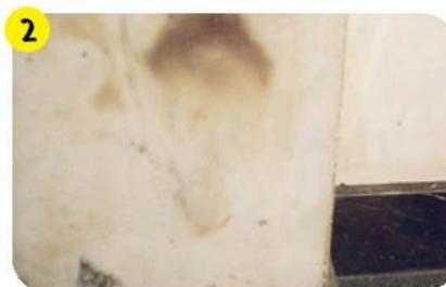
Если плиточный клей содержит речной песок с высоким содержанием железа, то на поверхности облицовки и в межплиточных швах может пропустить желтый налет, пятна.
