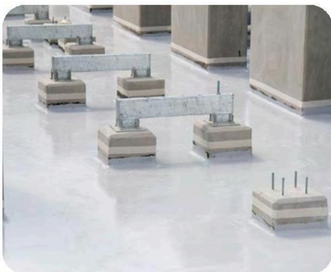
Vetonit PUR seal – жидкую однокомпонентную полиуретановую мастику, образующую после застывания бесшовную гидроизоляционную высокоэластичную мембрану, рассчитанную на весь срок службы здания. Содержит растворитель.
