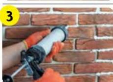
Для заполнения швов клинкерной плитки или камня использовать строительный шприц-пистолет. Уплотните затирку с помощью расшивки для кладочных швов. Через 30–50 минут излишки затирки удалить щёткой.
