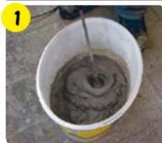
1 Необходимо провести подготовку поверхности (выравнивание, очистку, обеспыливание). В емкость с 5,0–5,75 л чистой воды засыпать 25 кг **weber.vetonit easy fix**. Смешать дрелью-миксером до однородной массы. Дать отстояться 5 мин и еще раз перемешать.
