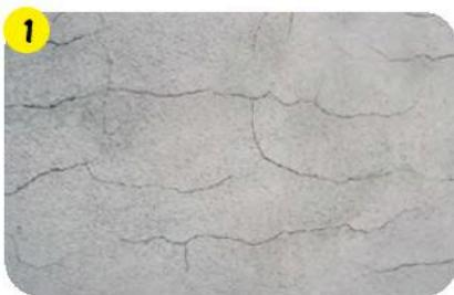
В незащищенный фасад проникает вода и разрушает штукатурное покрытие. Здание теряет эстетичный внешний вид.
