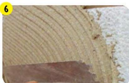
Нанести на поверхность фасада раствор **webertherm S100** с помощью зубчатого шпателя (размер зуба 10 × 10 мм).
