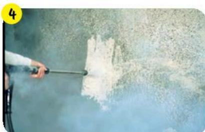
Поверхность фасада очистить при помощи горячей воды под высоким давлением.
