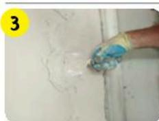
Приготовленный штукатурный раствор в течение 40 мин после затворения набросать на поверхность кельмой слоем 5–50 мм, локально – до 100 мм, после чего разровнять правилом.
